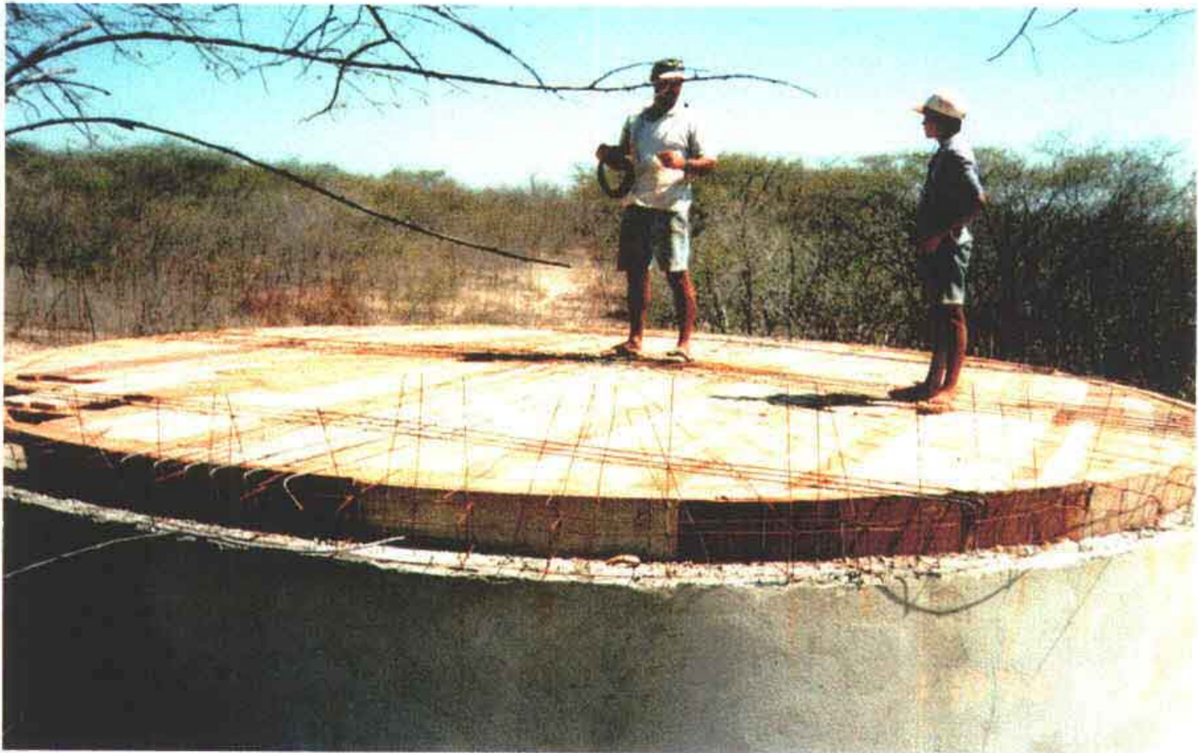
Foto 19 – Preparo da forma e ferragem da tampa do reservatório apoiado de 100 m 3 .
