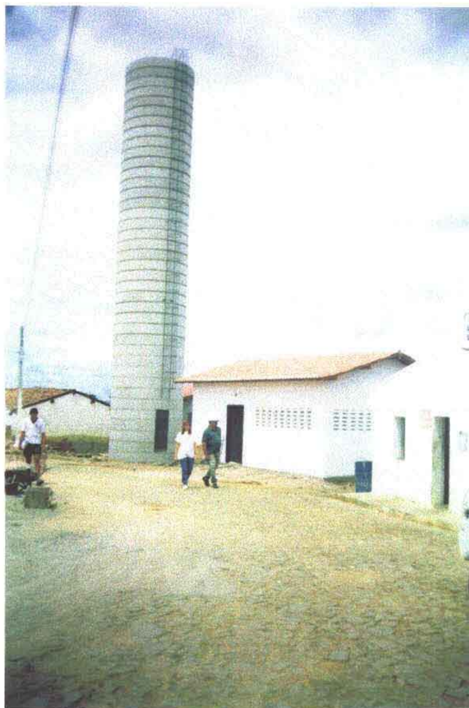
Foto 21 – Casa de química e reservatório elevado de 80 m 3 na ETA.
