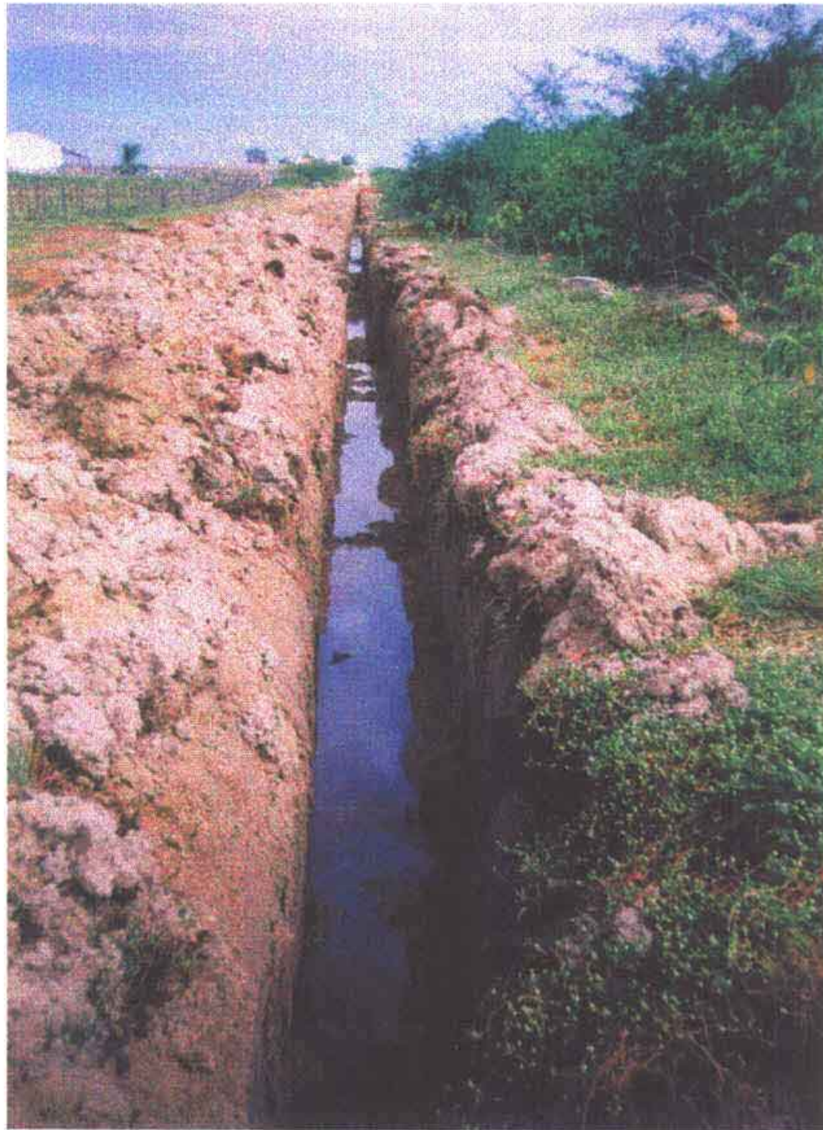
Foto 09 – Vala escavada em trecho que o lençol freático está acima da cota de assentamento dos tubos.
