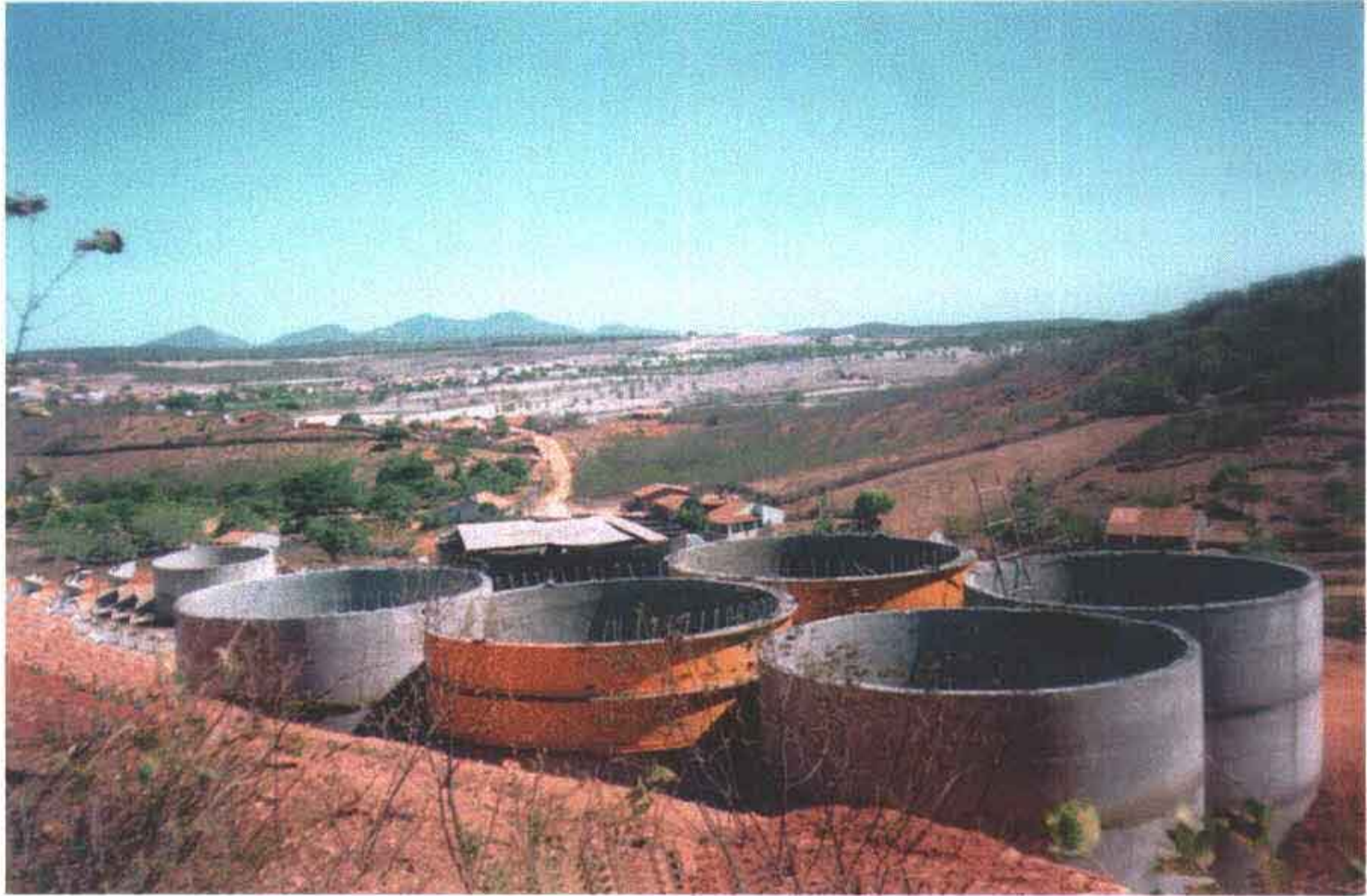
Foto 32 – Concretagem do reservatório apoiado de 300 m 3 .
