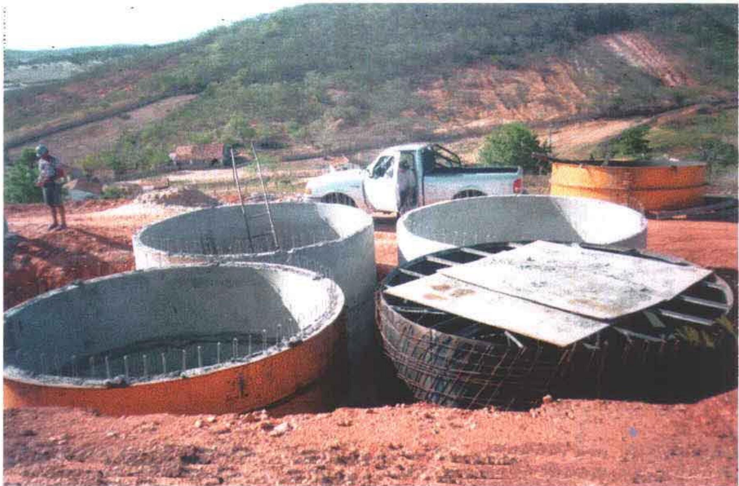
Foto 31 – Forma e ferragem do reservatório apoiado de 300 m 3 .
