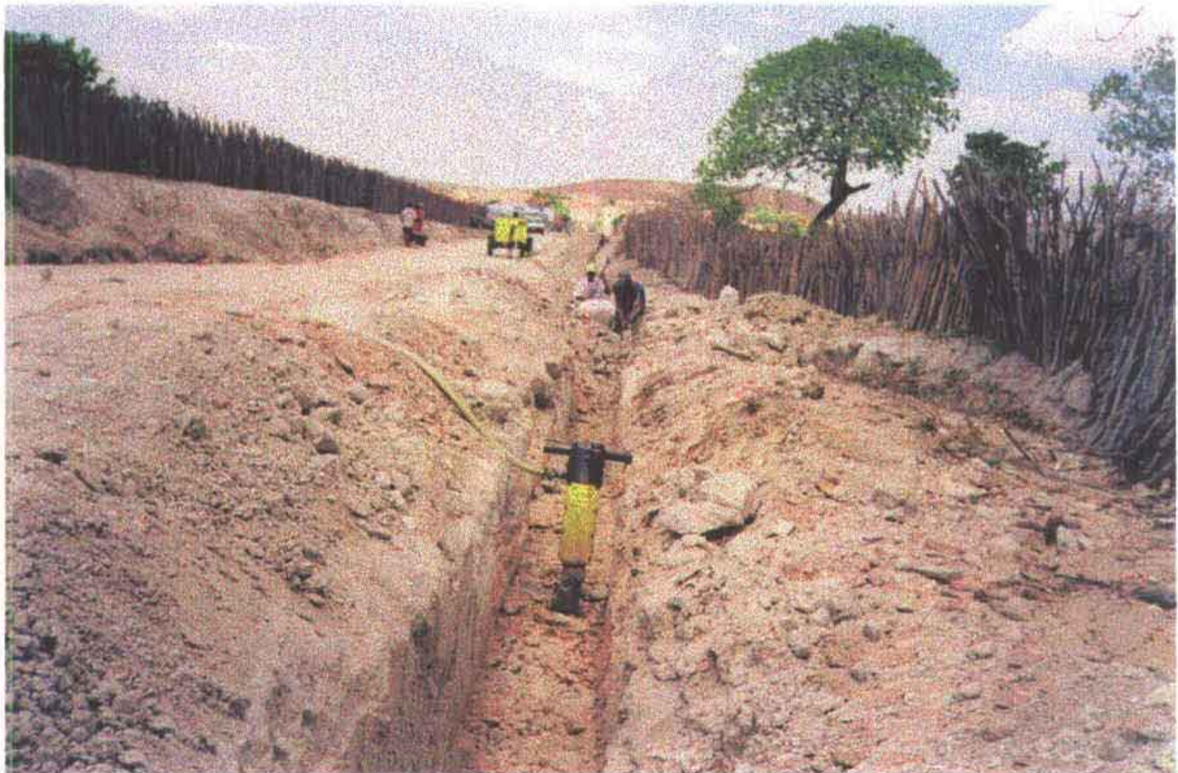
Foto 06 – Vala assentamento dos tubos RPVC e reaterro.
