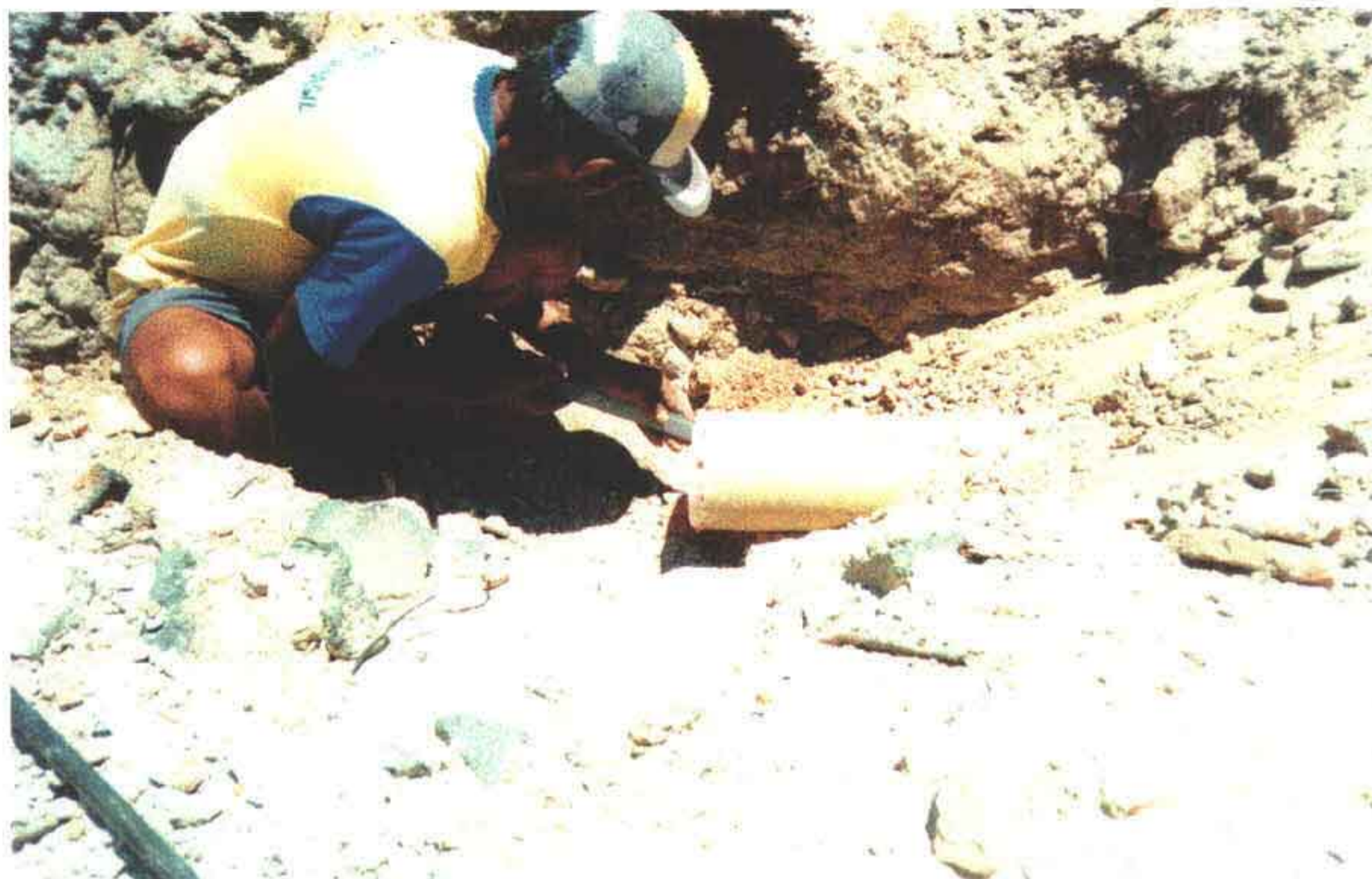
Foto 12 – Corte do tubo e execução do chanfro.
