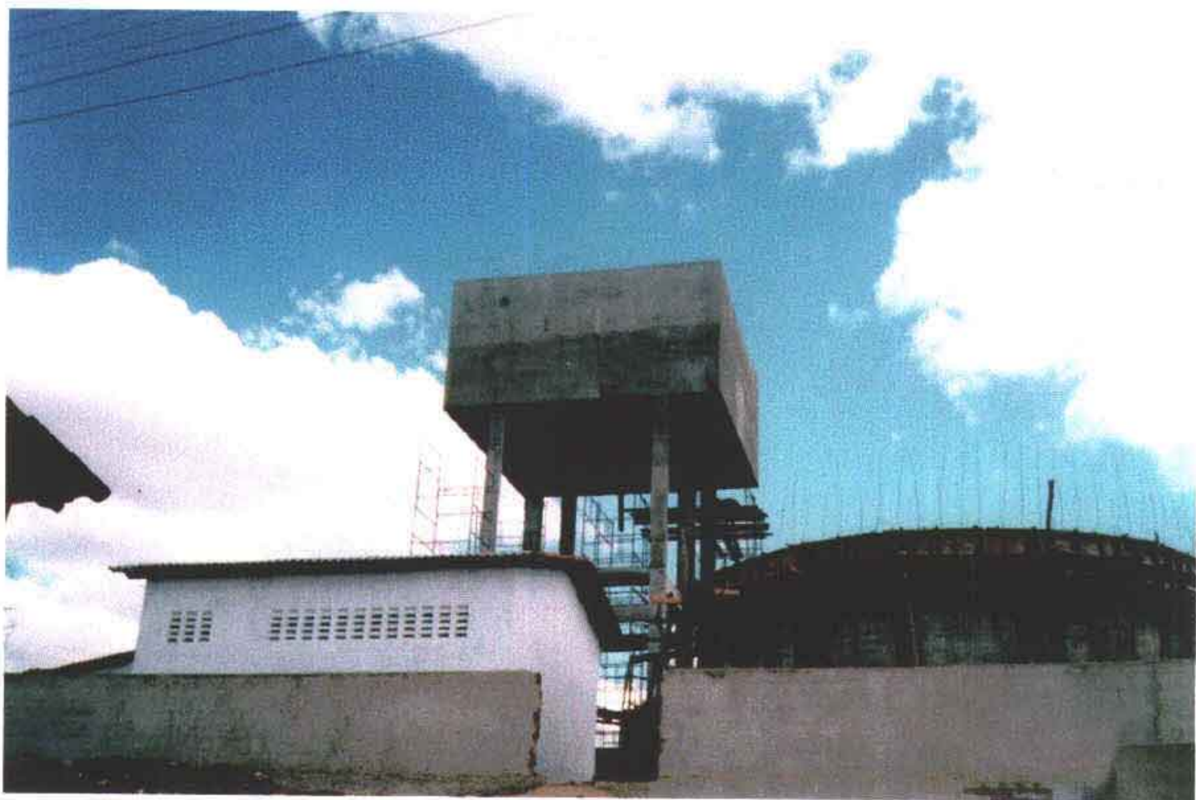
Foto 28 – Recuperação do reservatório elevado de 200 m 3 .
