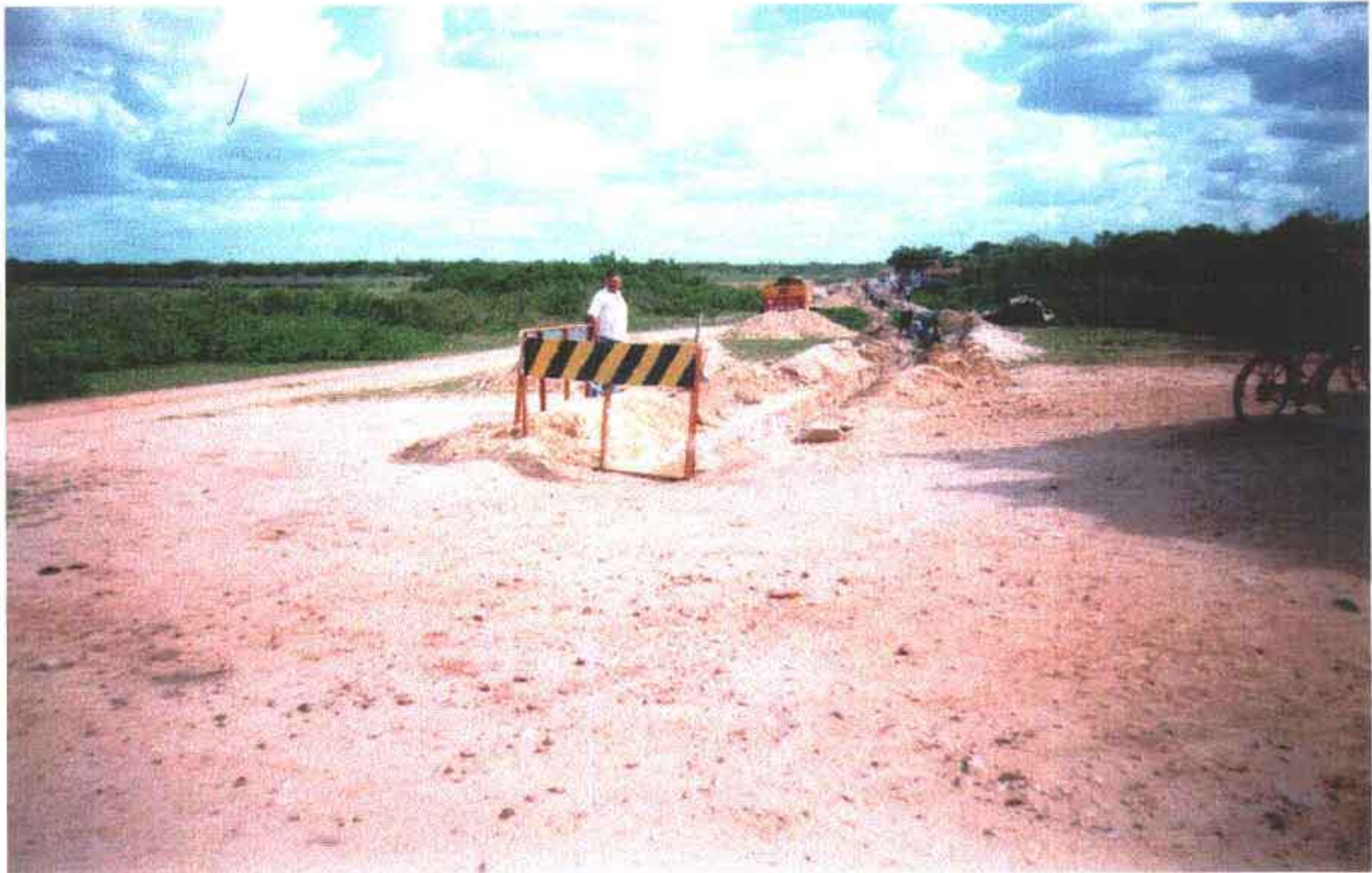
Foto 01 – Sinalização de barreira p/proteção de valas.
