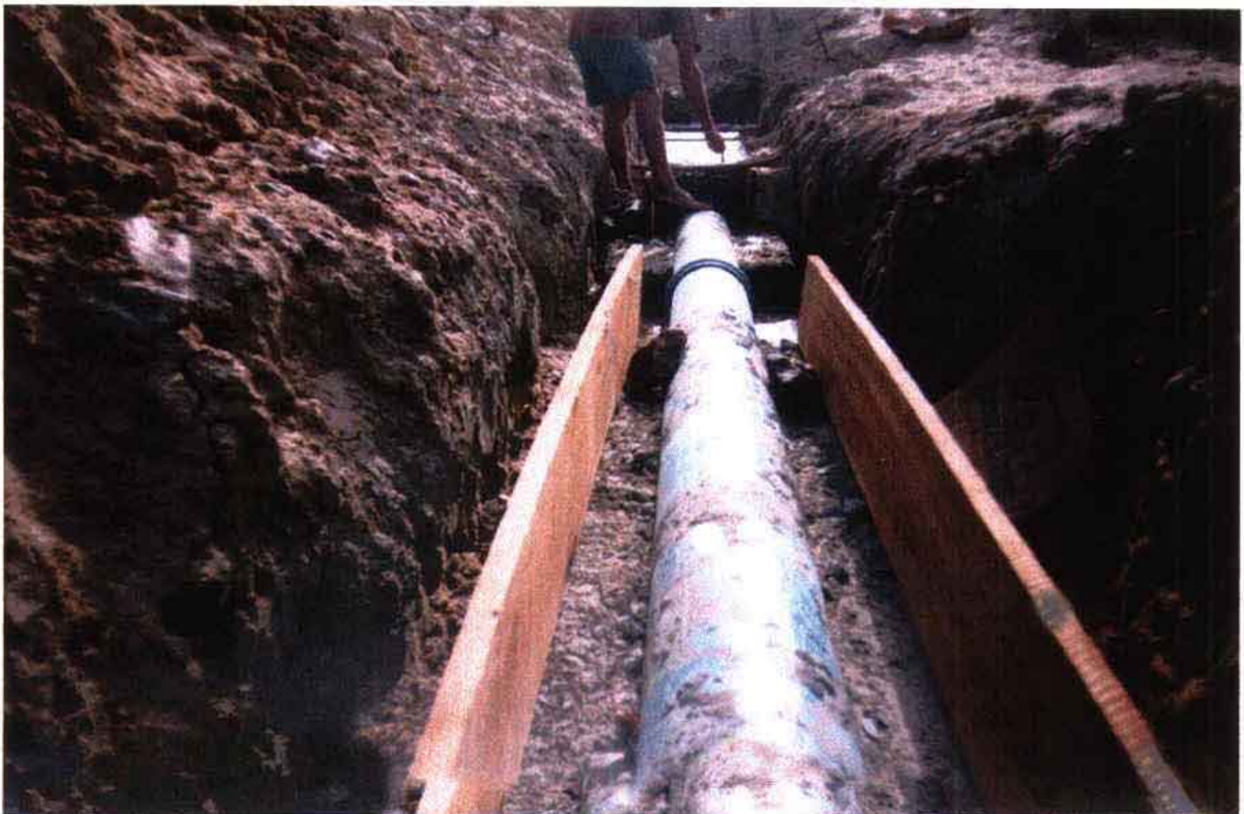
Foto 04 – Execução de envelopamento em trecho da adutora.
