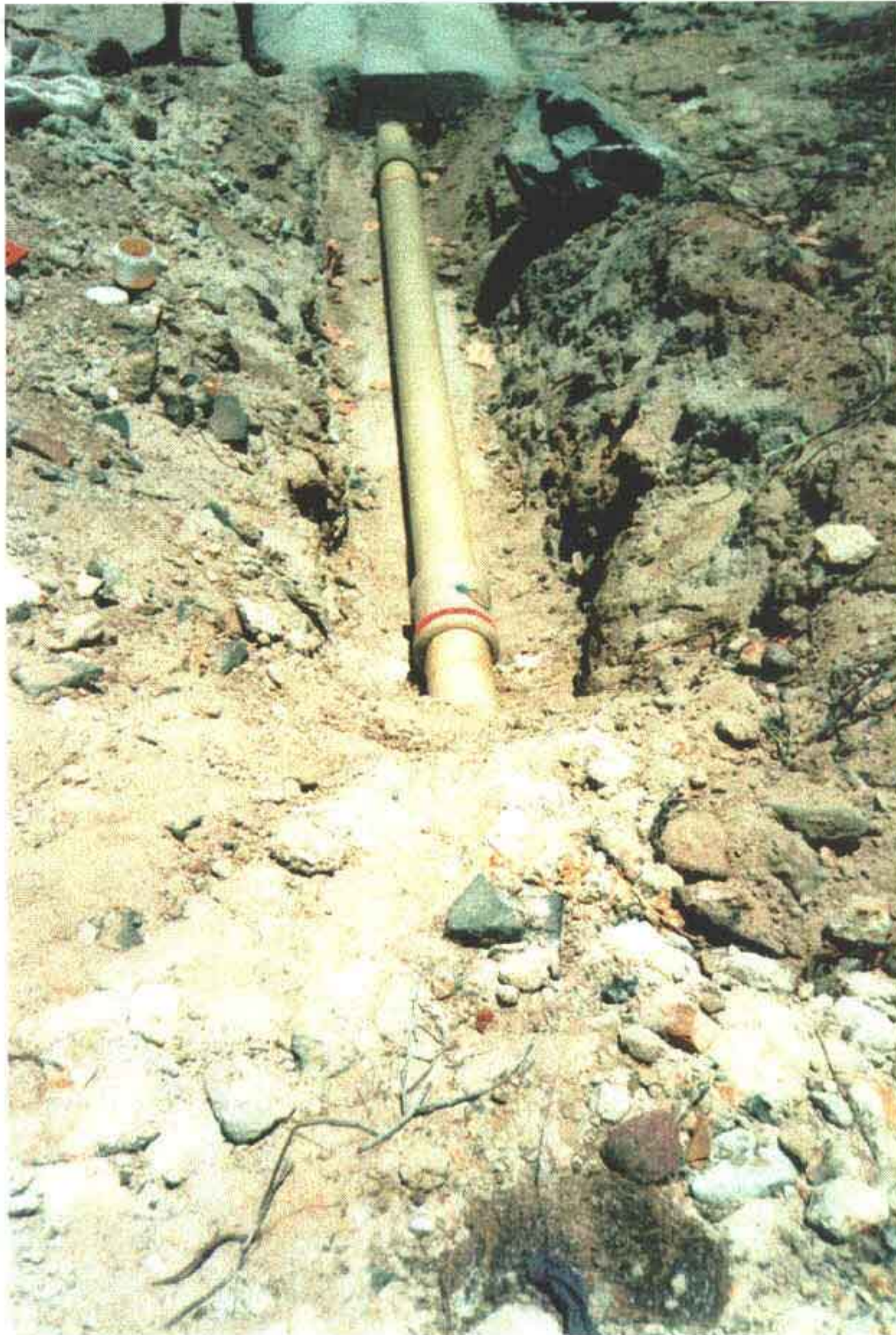
Foto 17 – Vista do tubo emendado.
