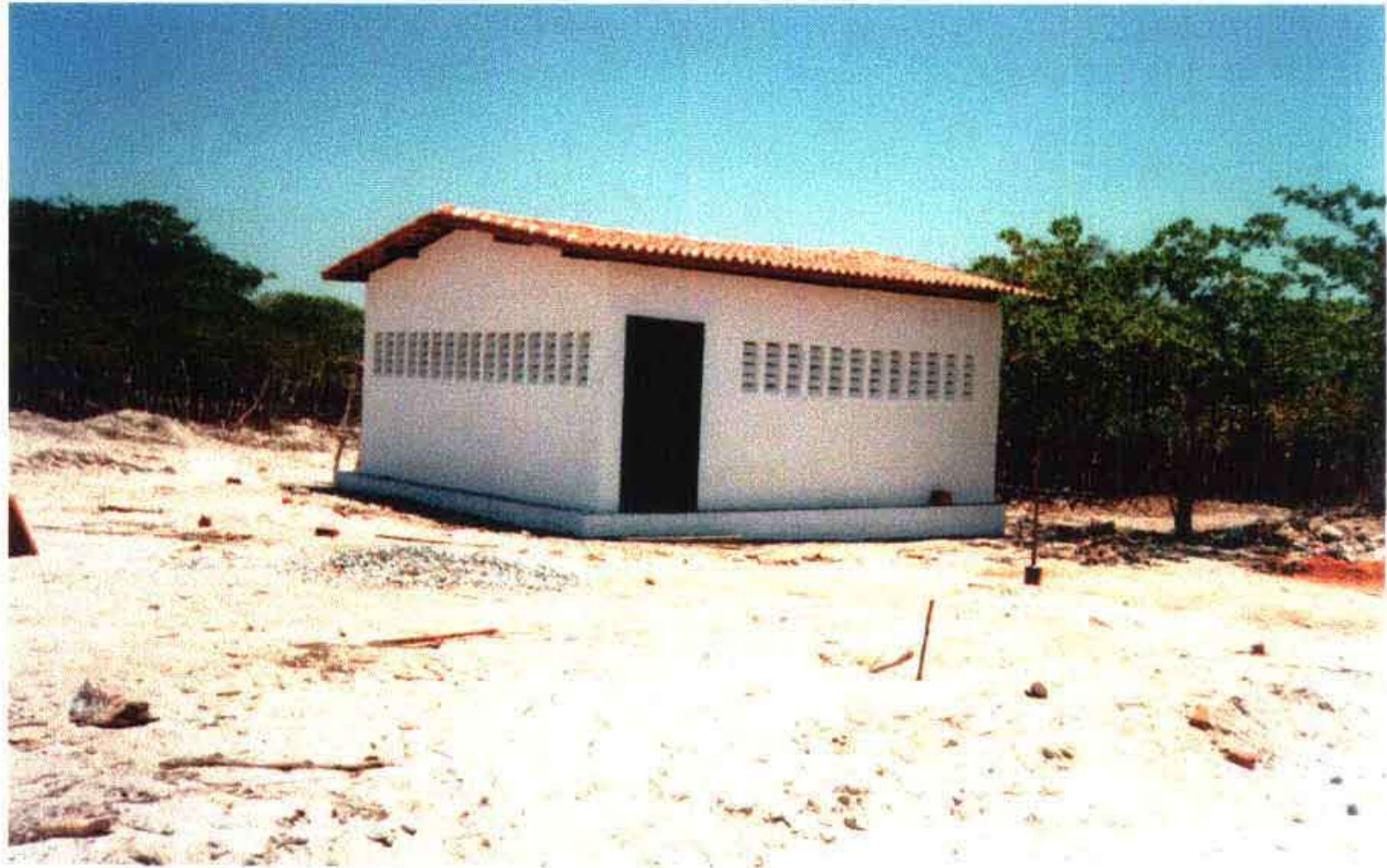
Foto 21 – Vista da casa de bombas da estação elevatória EE-2.
