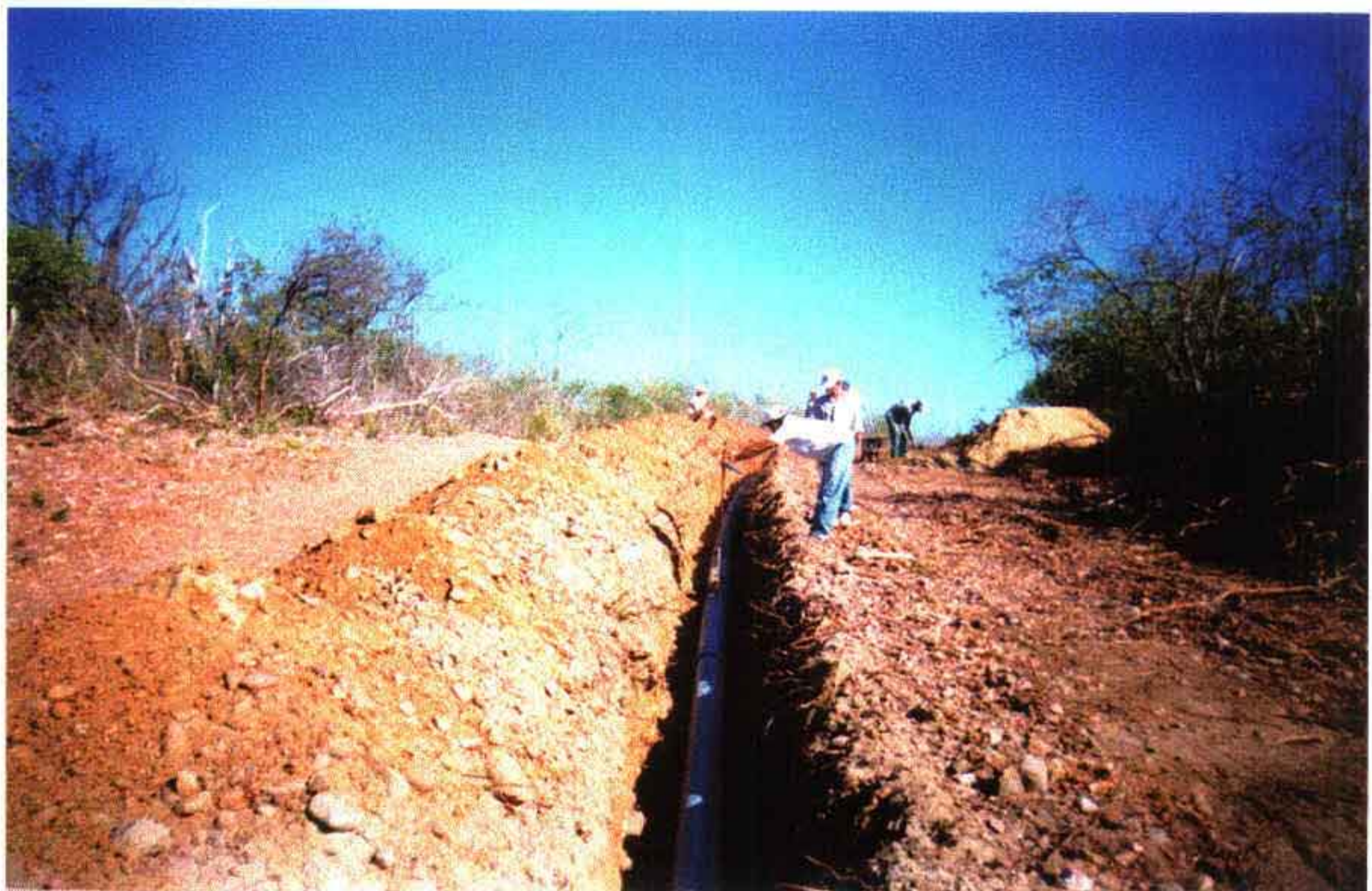
Foto 22 – Verificação pelo topógrafo da consultora do desenvolvimento da curva na estaca 943.
