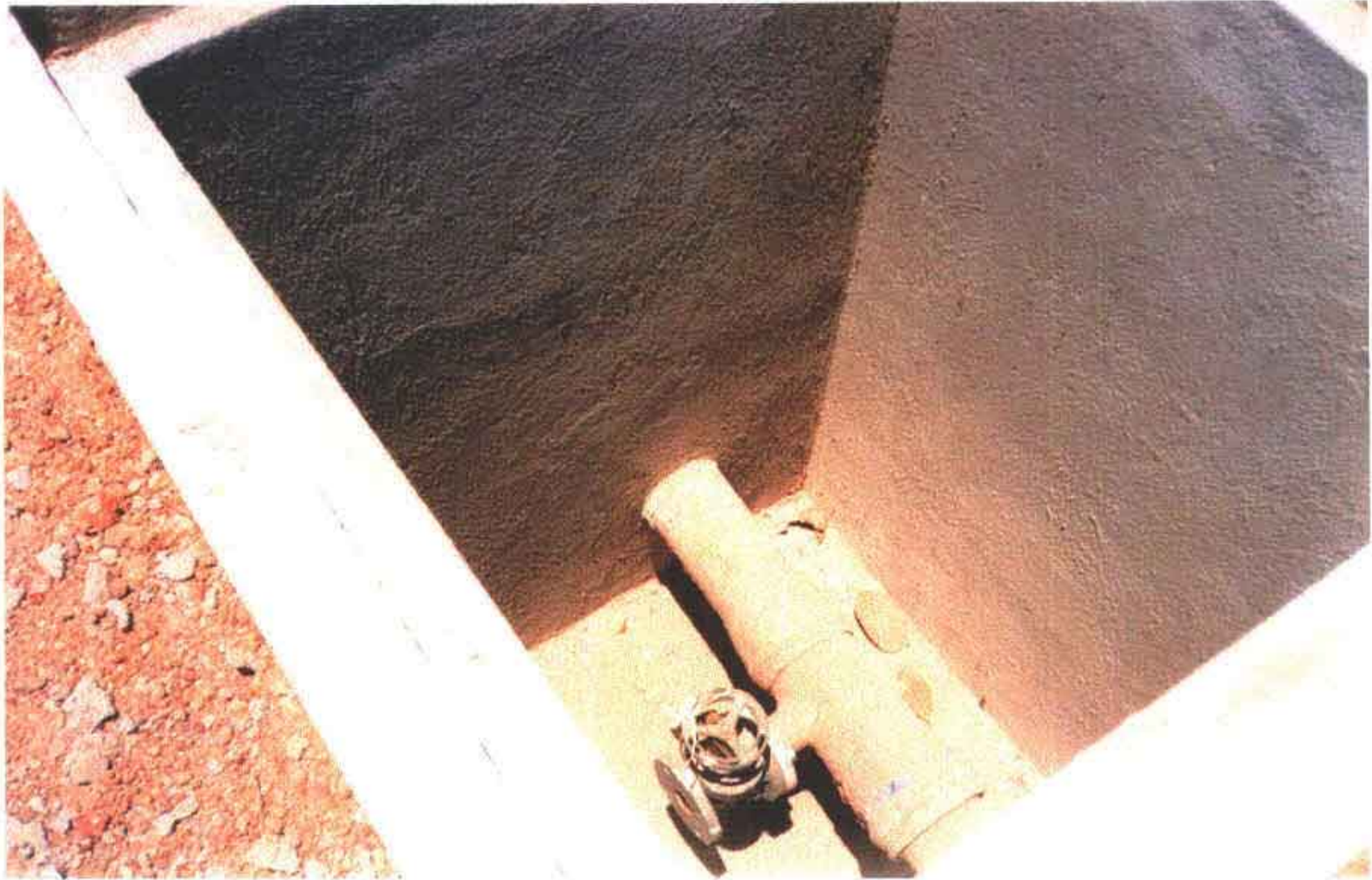
Foto 07 – Registro de descarga. Faltando acoplar o tubo de descarga.
