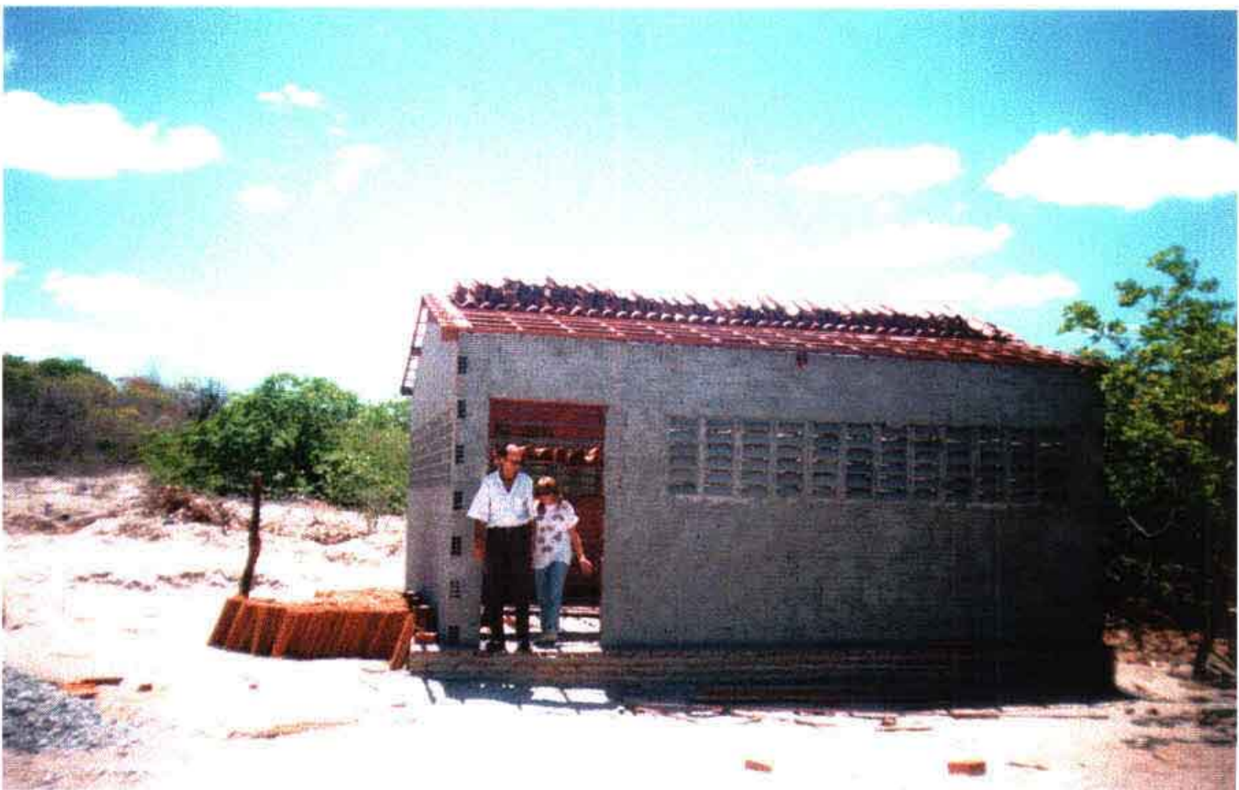
Foto 20 – Casa de bombas da estação elevatório EE-2 em conservação.
