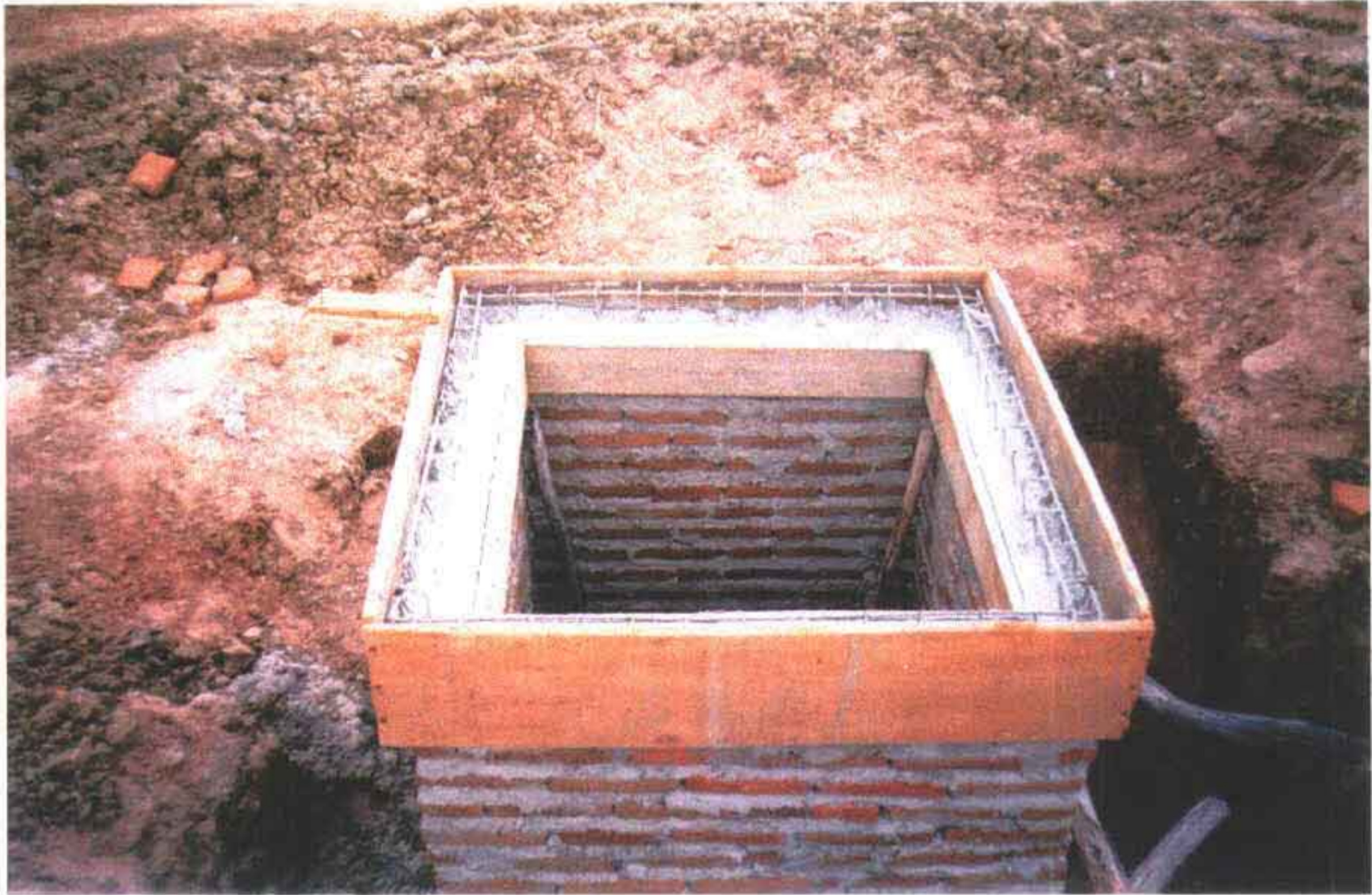
Foto 05 – Caixa para registro – Detalhe da cinta de apoio da tampa.
