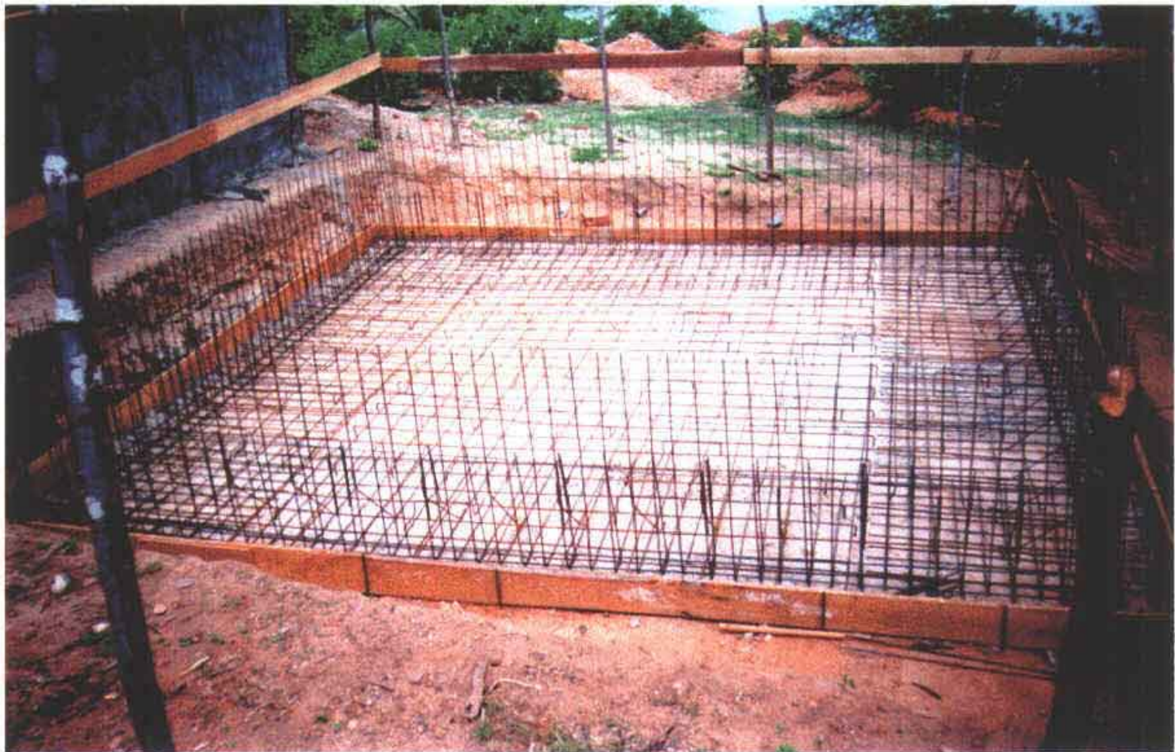
Foto 09 – Reservatório de 50 m 3 em construção, parte integrante da EE-2.
