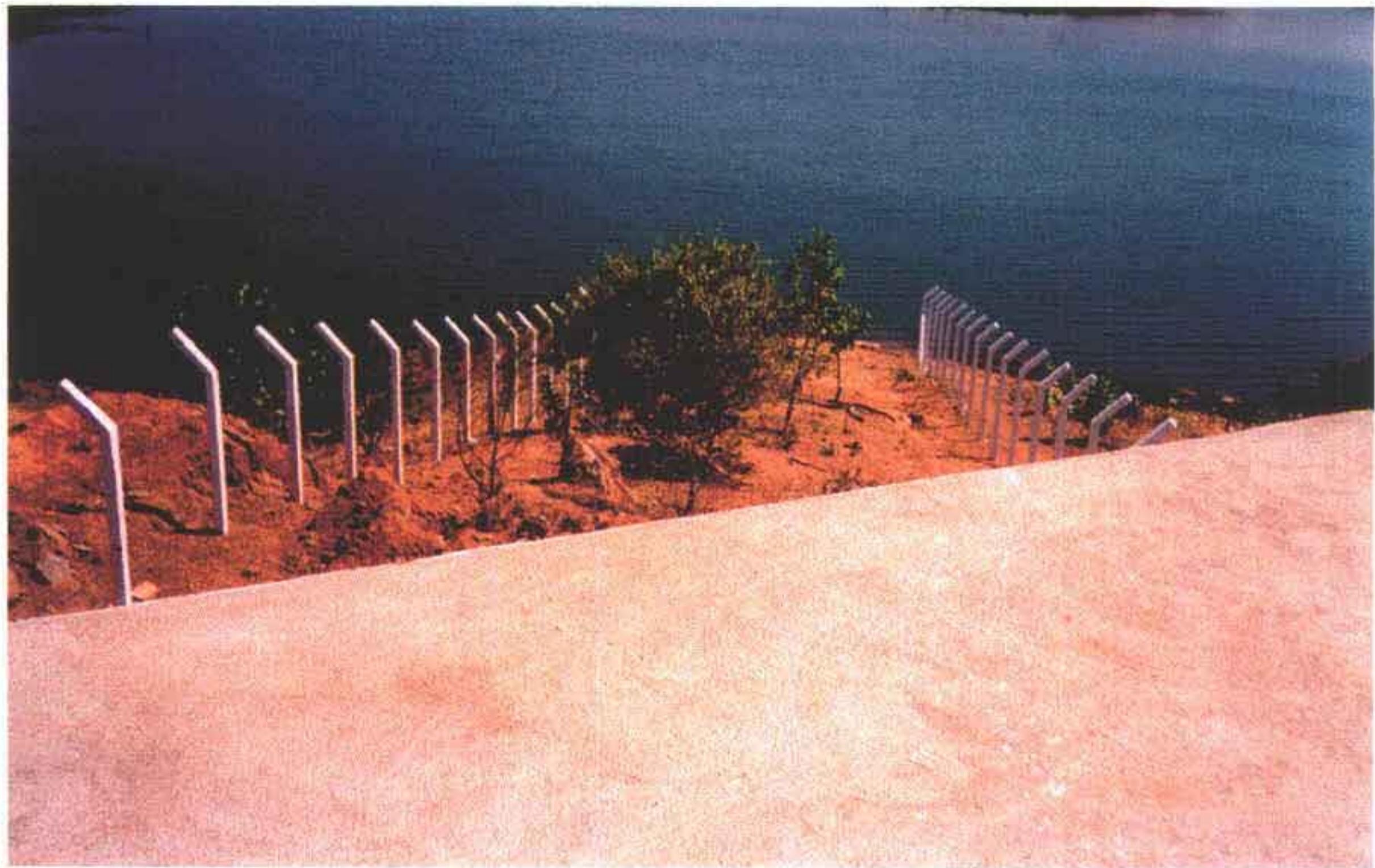
Foto 15 – Local da captação no açude São José e cerca de proteção.
