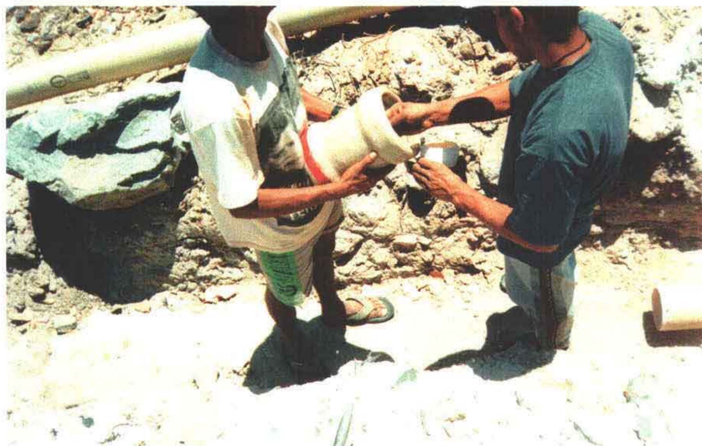
Foto 13 – Colocação do anel e pasta na luva de correl.
