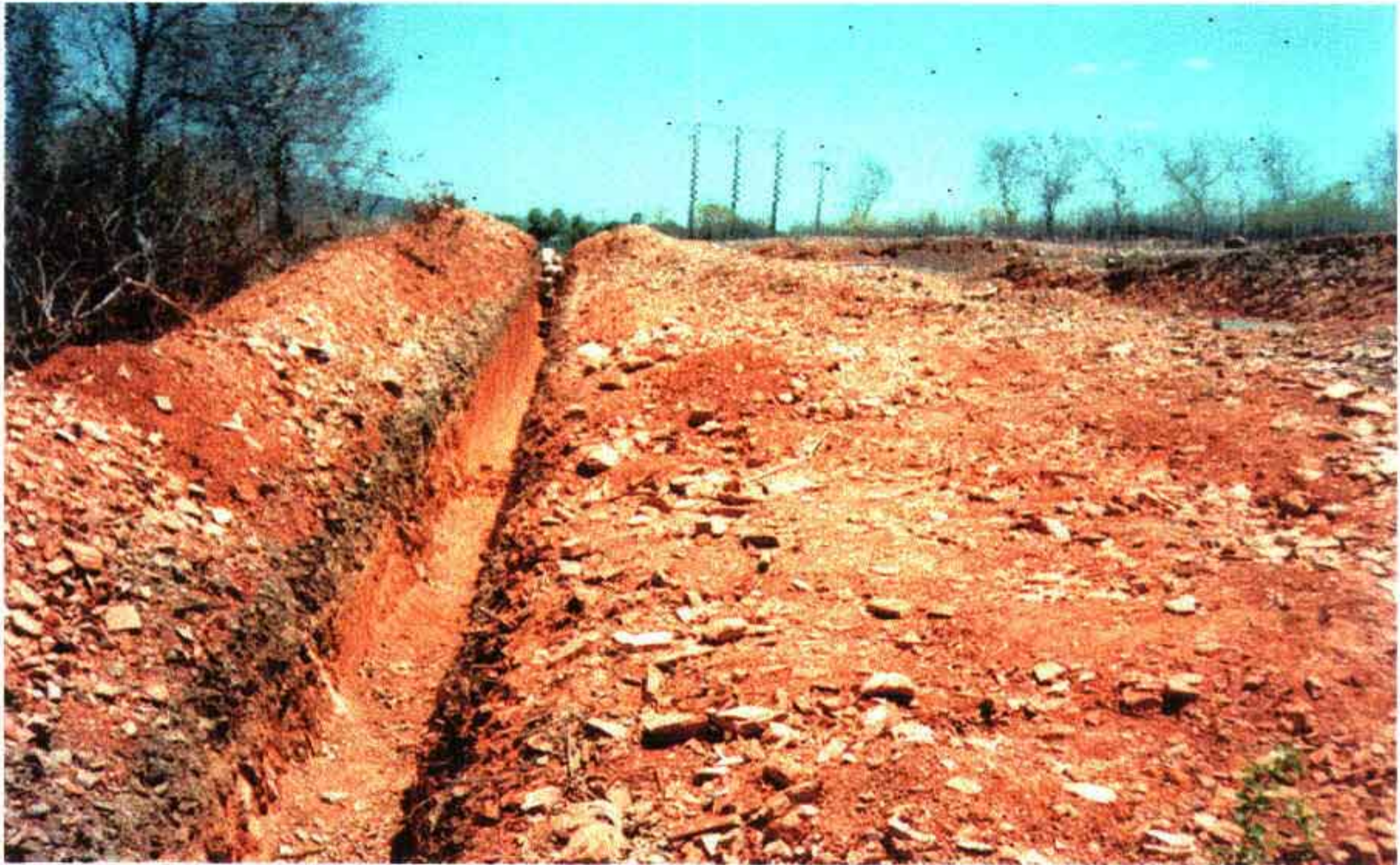
Foto 13 – Escavação da vala próximo ao cruzamento da CE-123.
