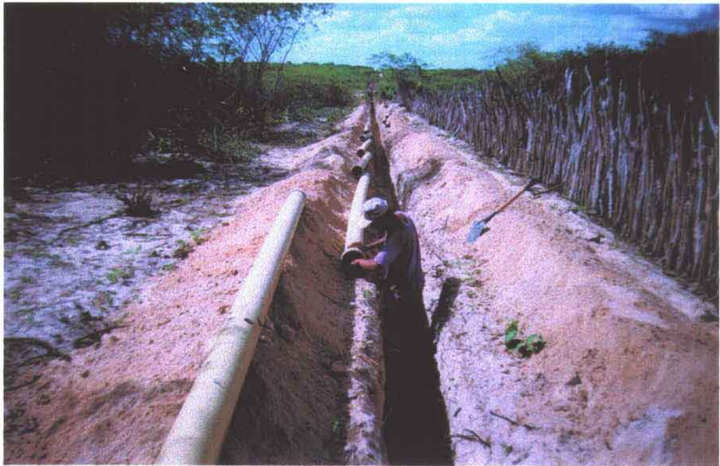
Foto 03 – Preparação dos tubos para serem assentados.
