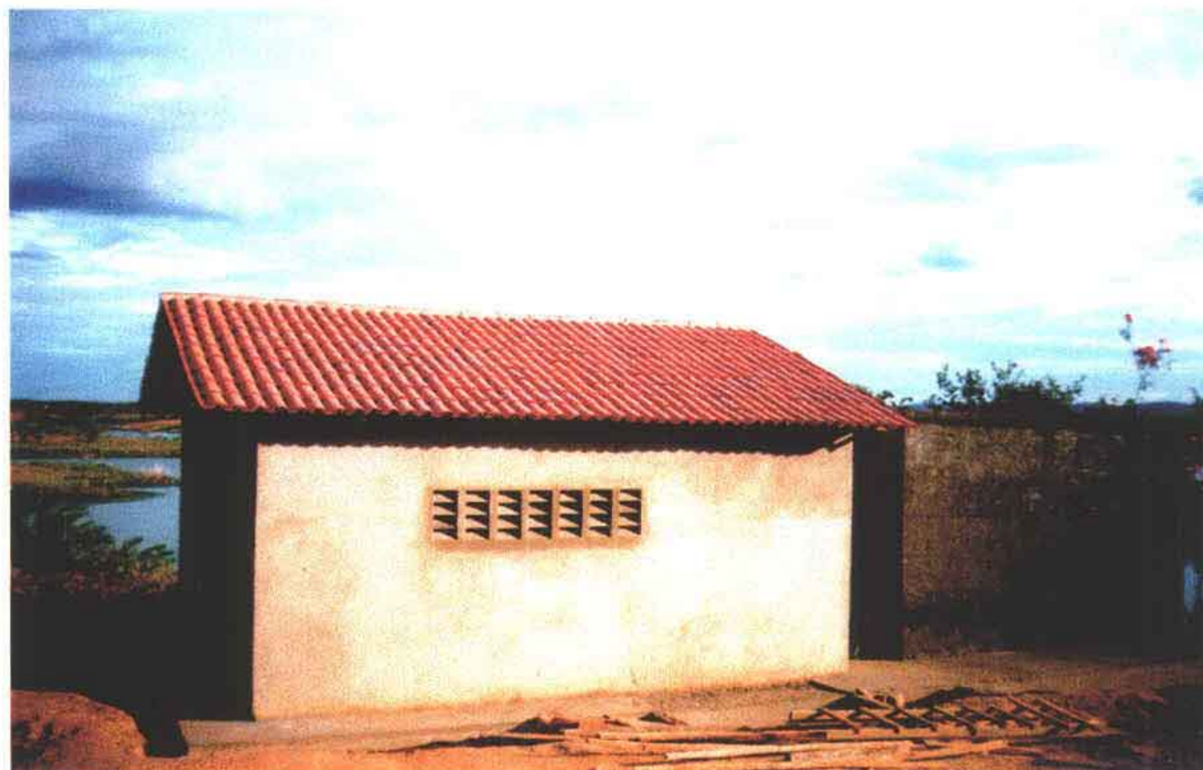
Foto 12 – Estação elevatória EE-2 em fase de conclusão.
