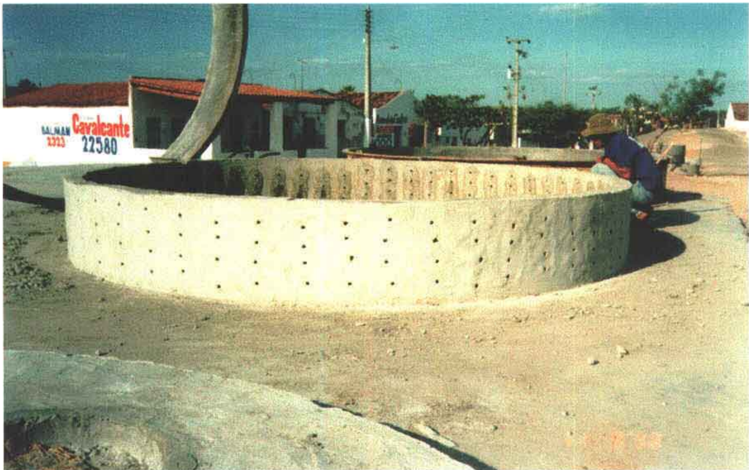
Foto 10 – Vista de um anel premoldado para execução do filtro do poço amazonas no Rio Banabuiú – Captação.
