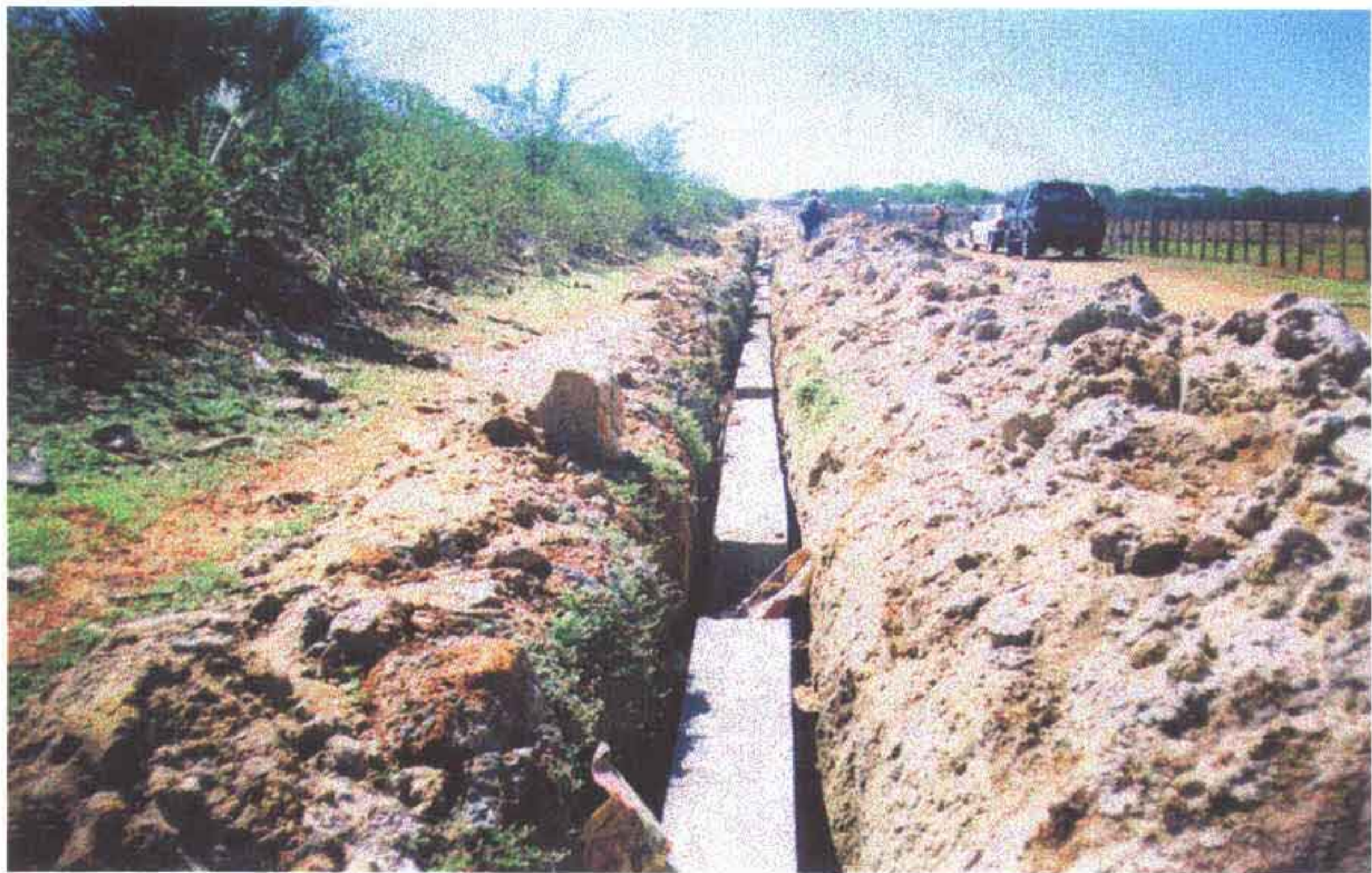
Foto 11 – Envolvimento no trecho onde o lençol freático está acima da Geratriz Superior do tubo.
