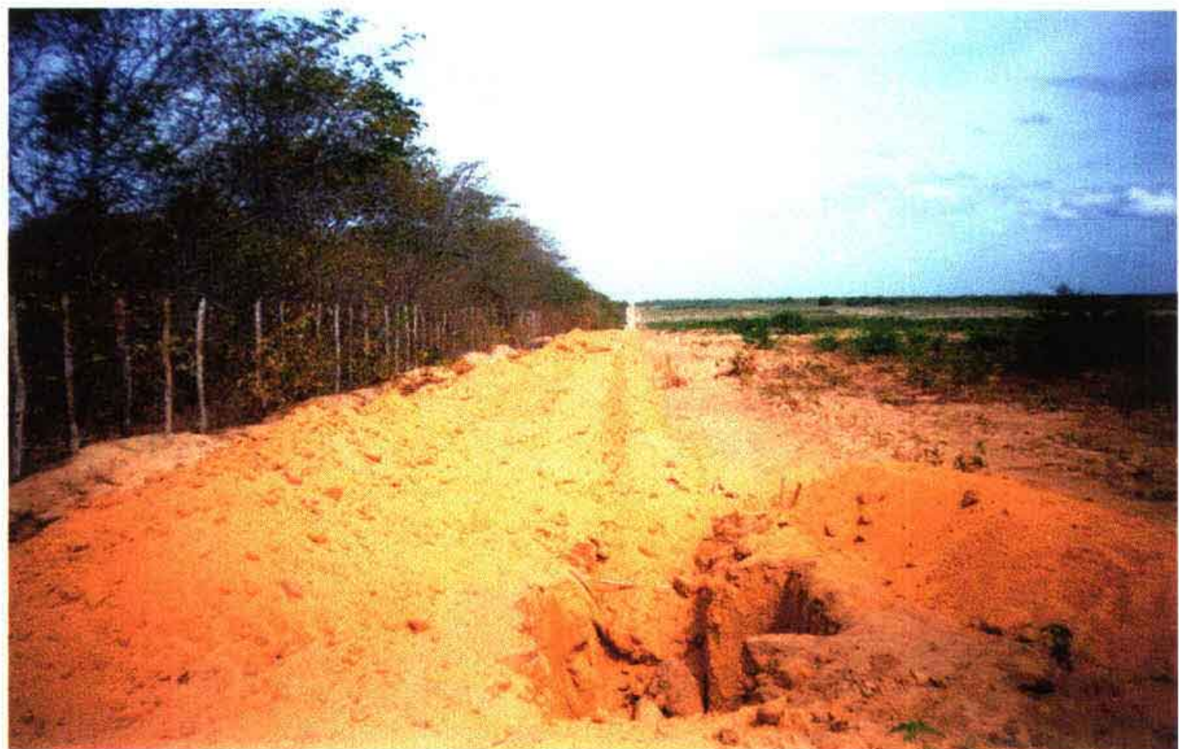
Foto 10 – Reaterro da vala e espalhamento de material.
