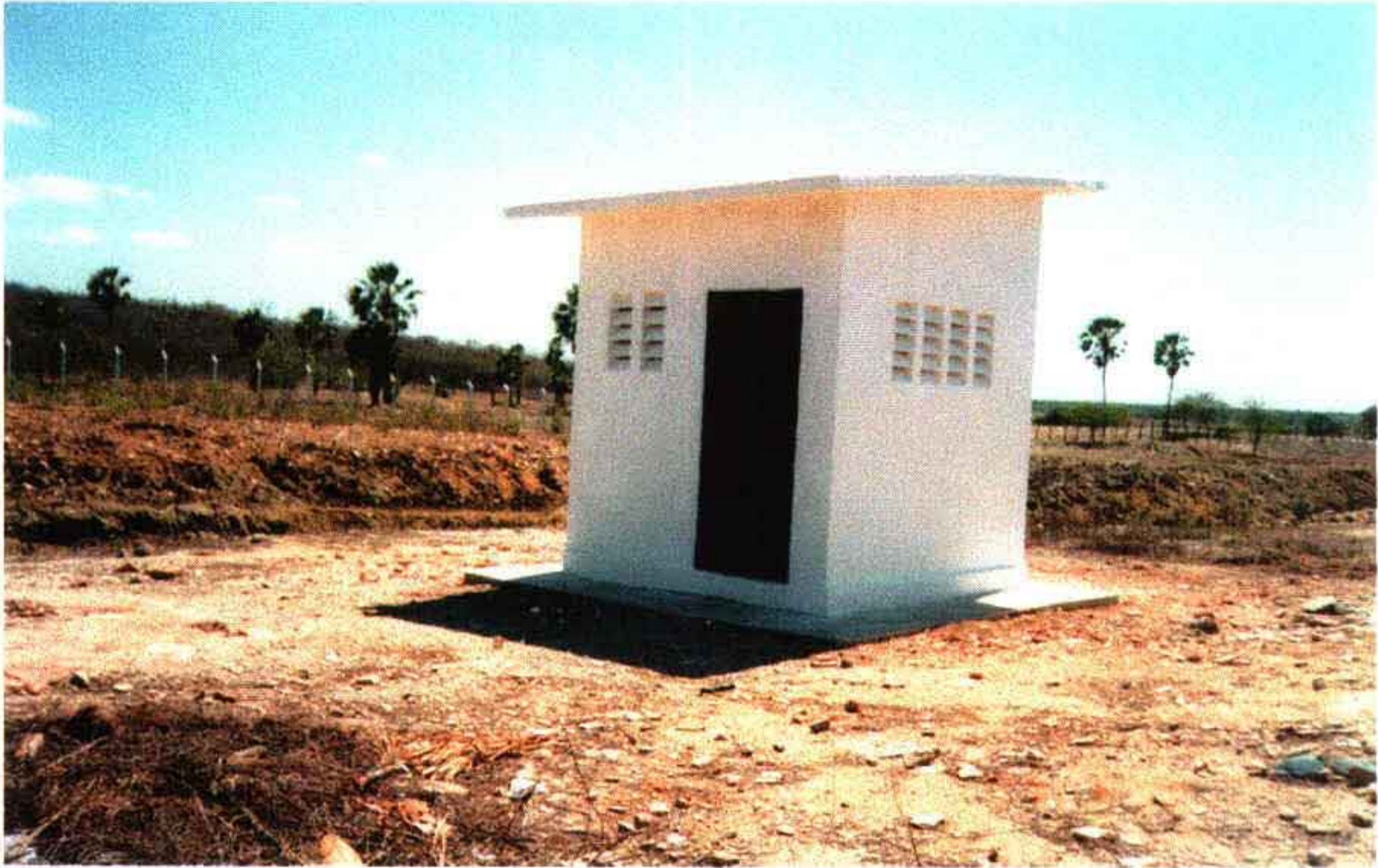
Foto 19 – Casa de comando das bombas na captação na margem do canal do trabalhador.
