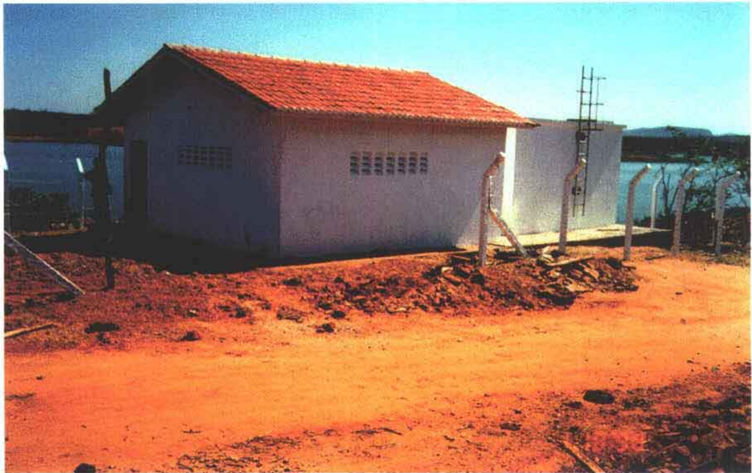
Foto 13 – Vista da estação EE-2.
