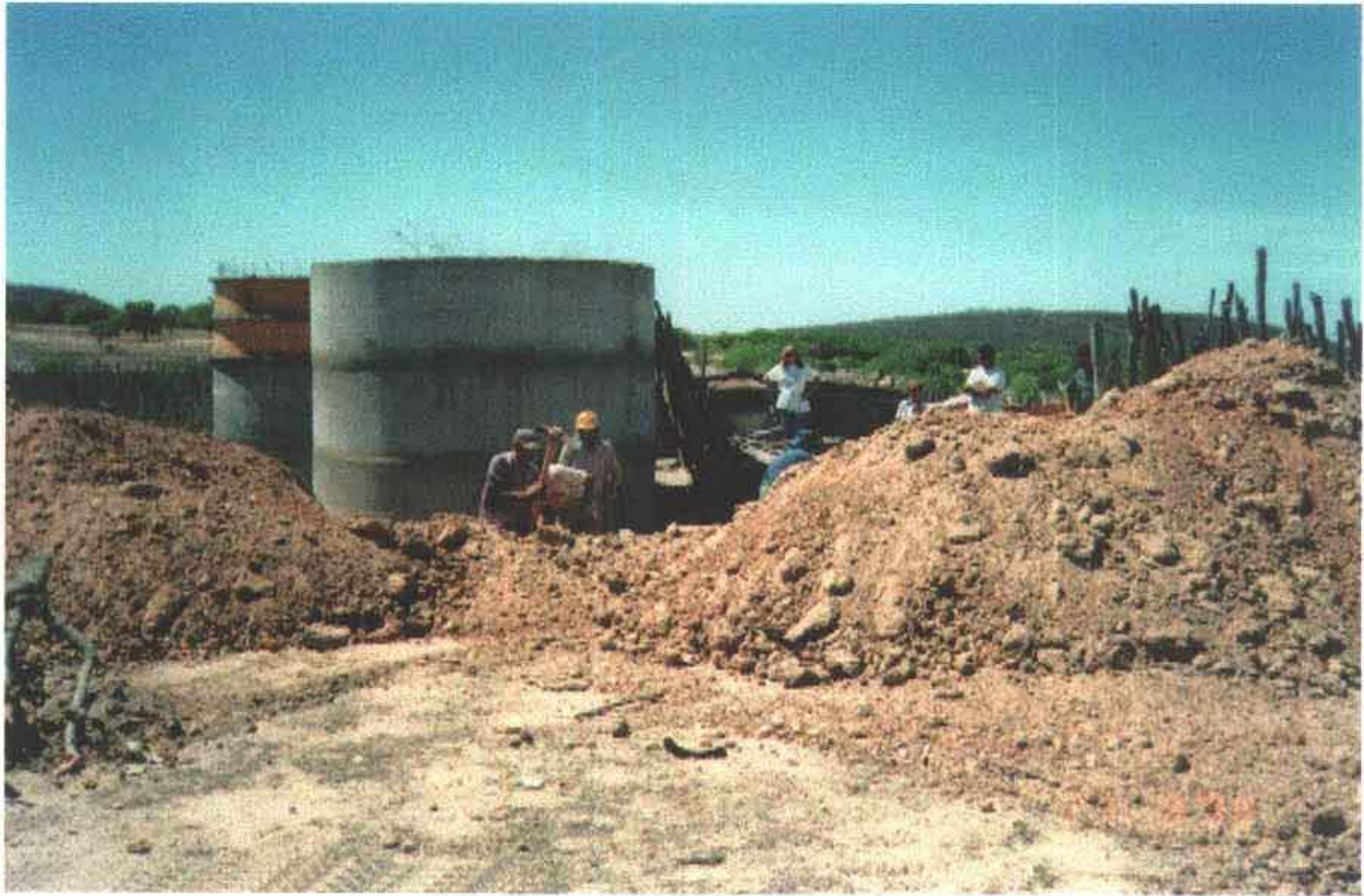
Foto 38 – Reservatório apoiado de 80 m 3 em execução.
