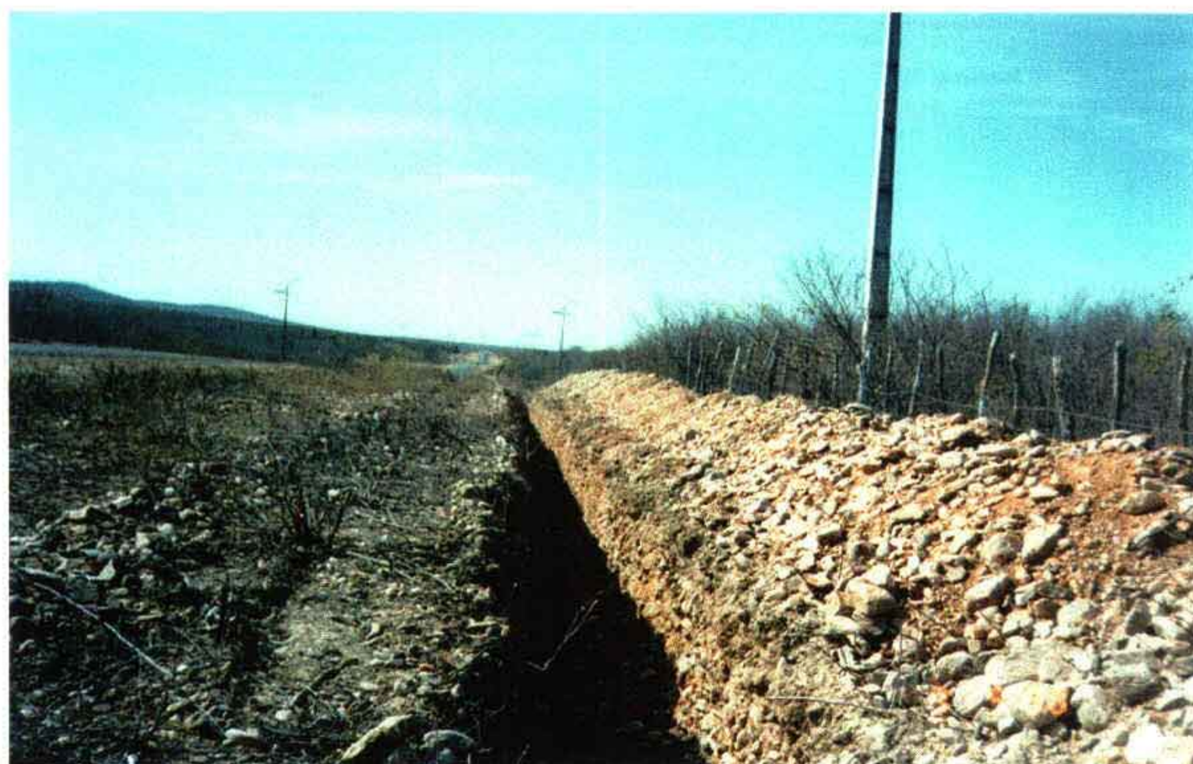
Foto 16 – Escavação de parte da vala – Detalhe do tipo do material escavado.
