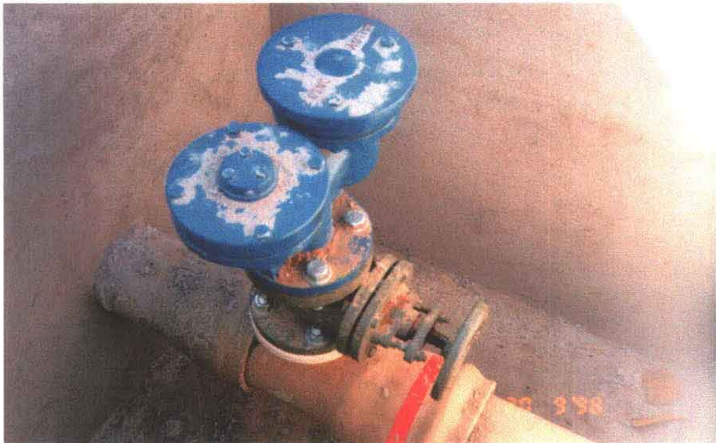
Foto 08 – Ventosa de tríplice função e registro de gaveta chato com flange e volante.
