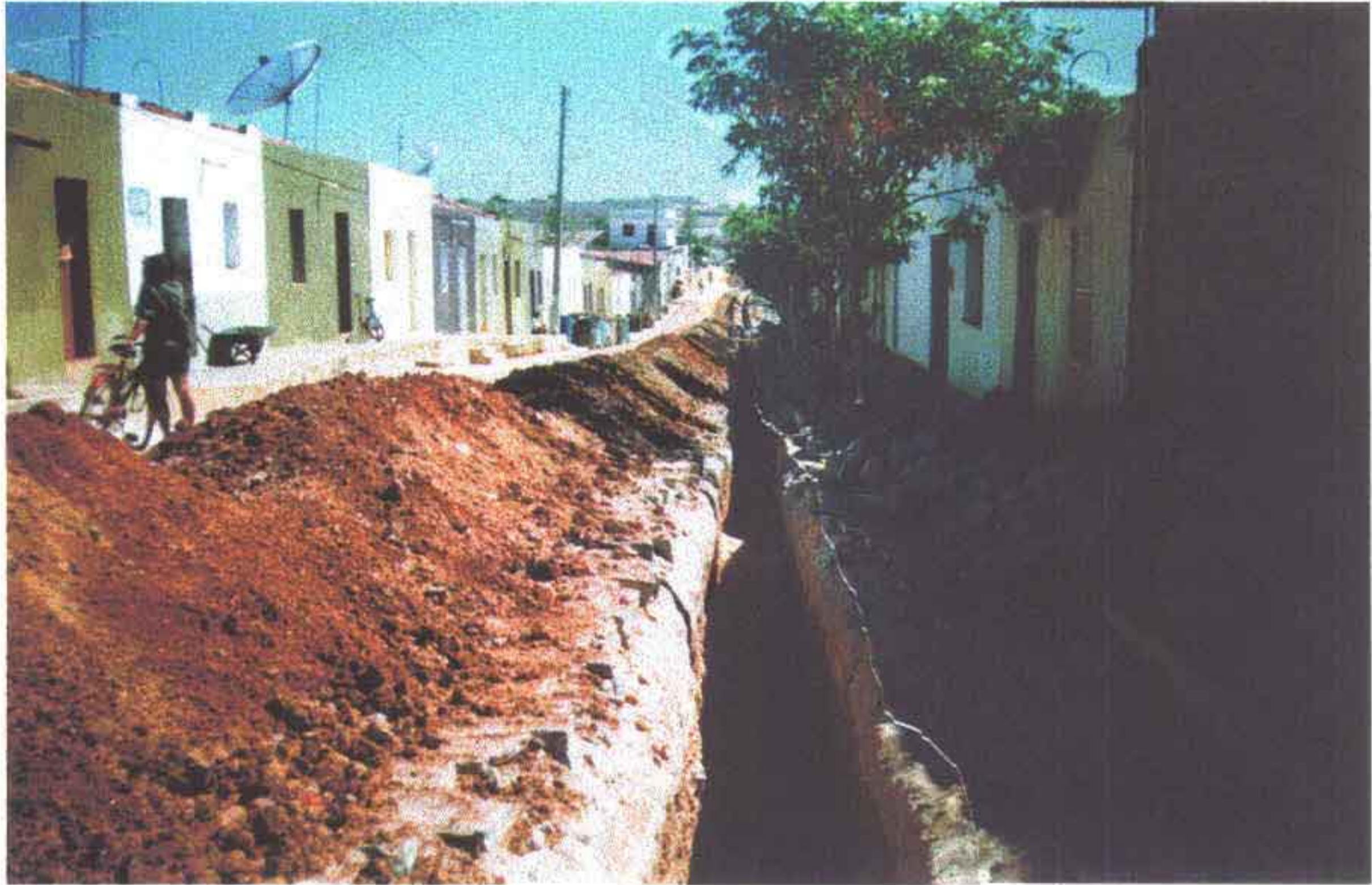
Foto 10 – Escavação no centro da cidade de Ibicuitinga.
