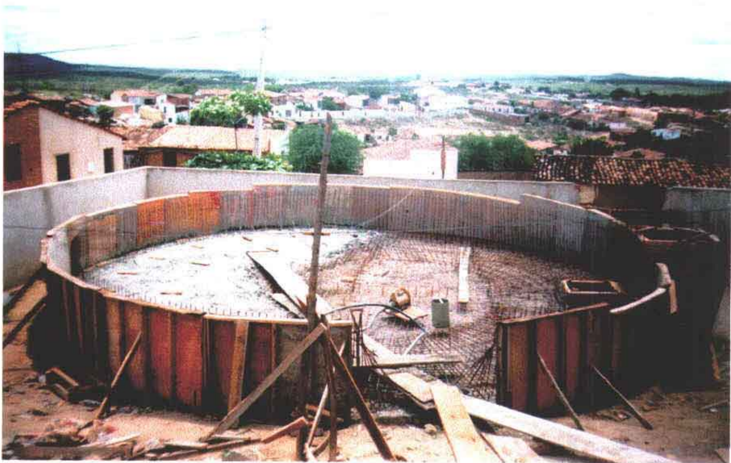
Foto 20 – Concretagem do fundo do reservatório apoiado de 200 m 3 da estação elevatória na ETA.
