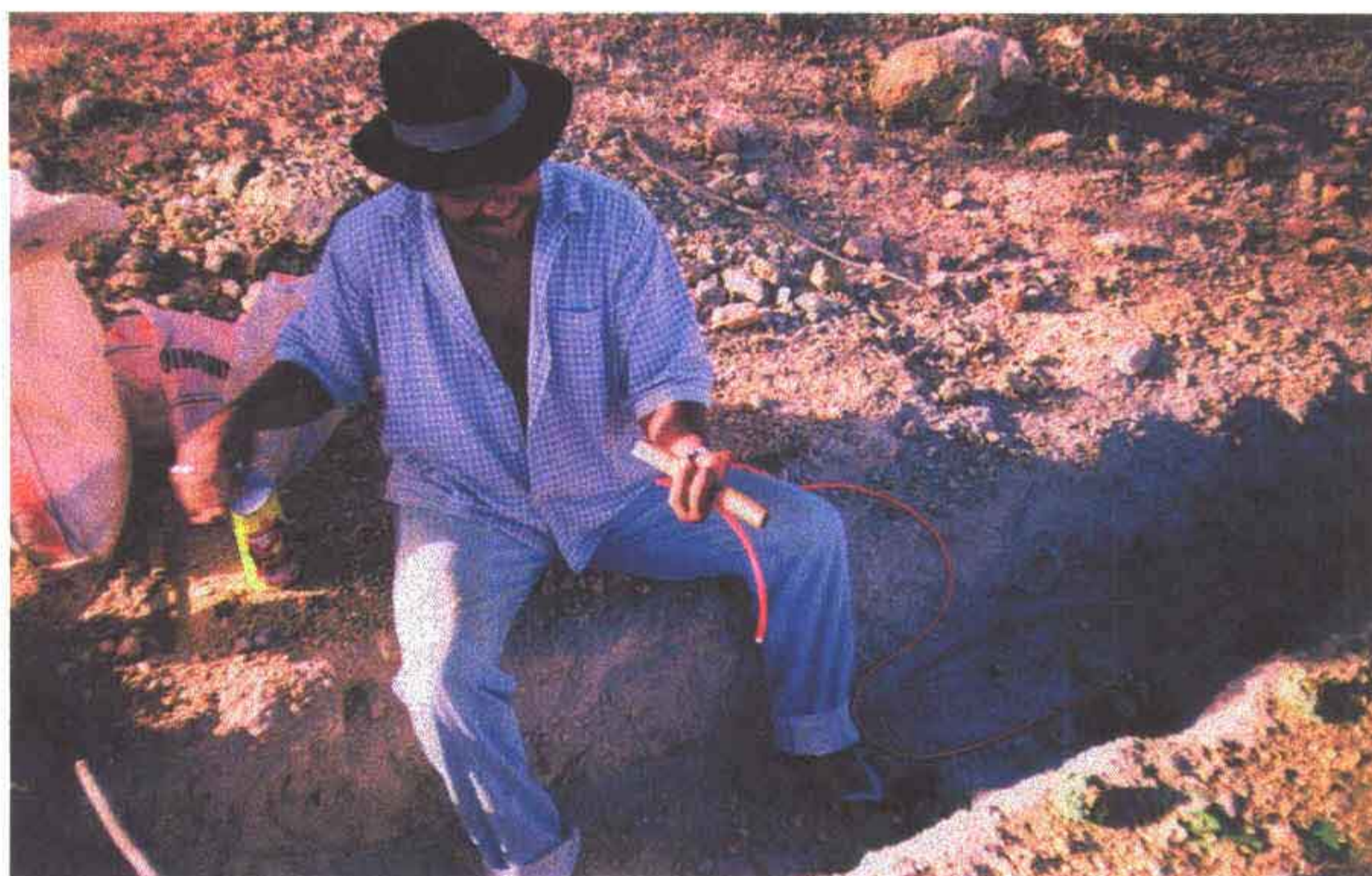
Foto 13 – Preparação de explosivo para abertura de valas.
