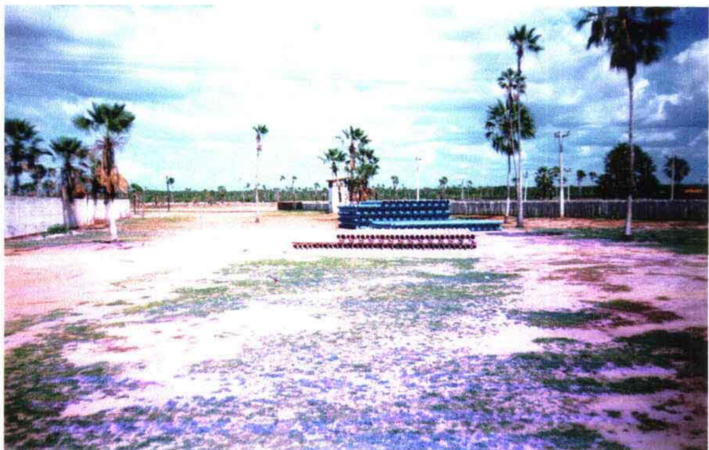
Foto 02 – Pátio para armazenamento dos tubos.
