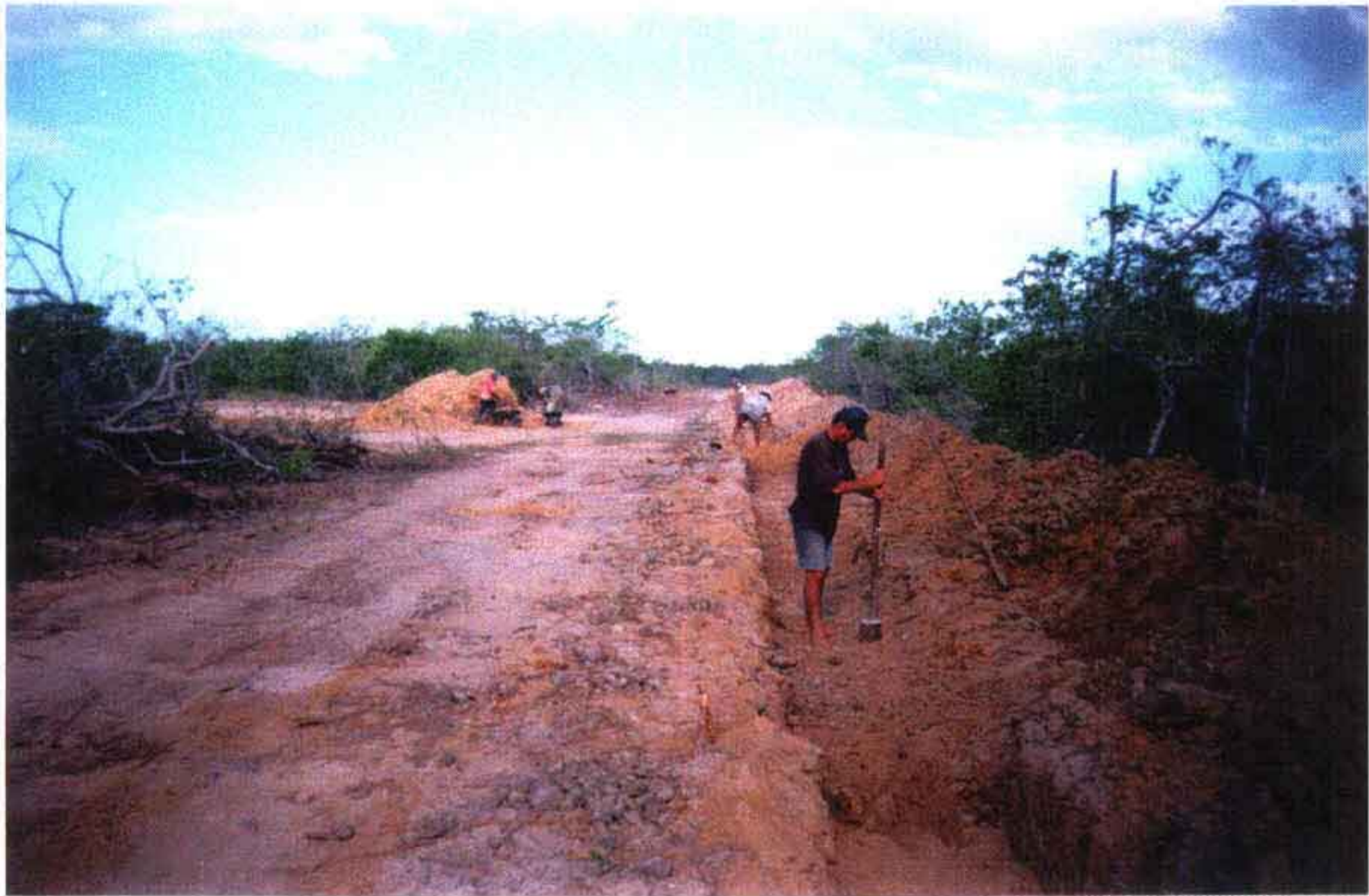
Foto 05 – Reaterro das valas em camadas.
