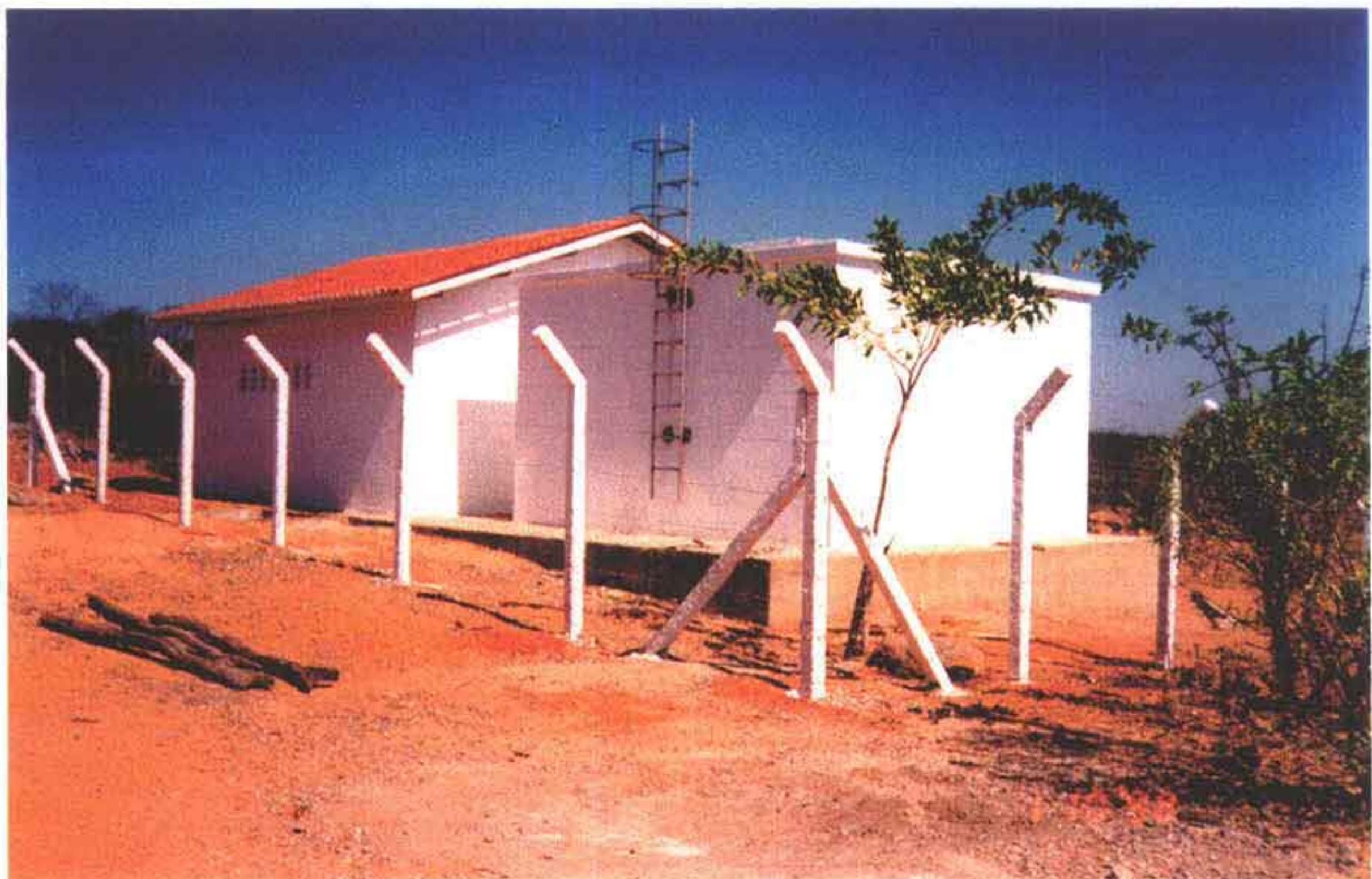
Foto 14 – Vista lateral da estação elevatória EE-2 e cerca de proteção.
