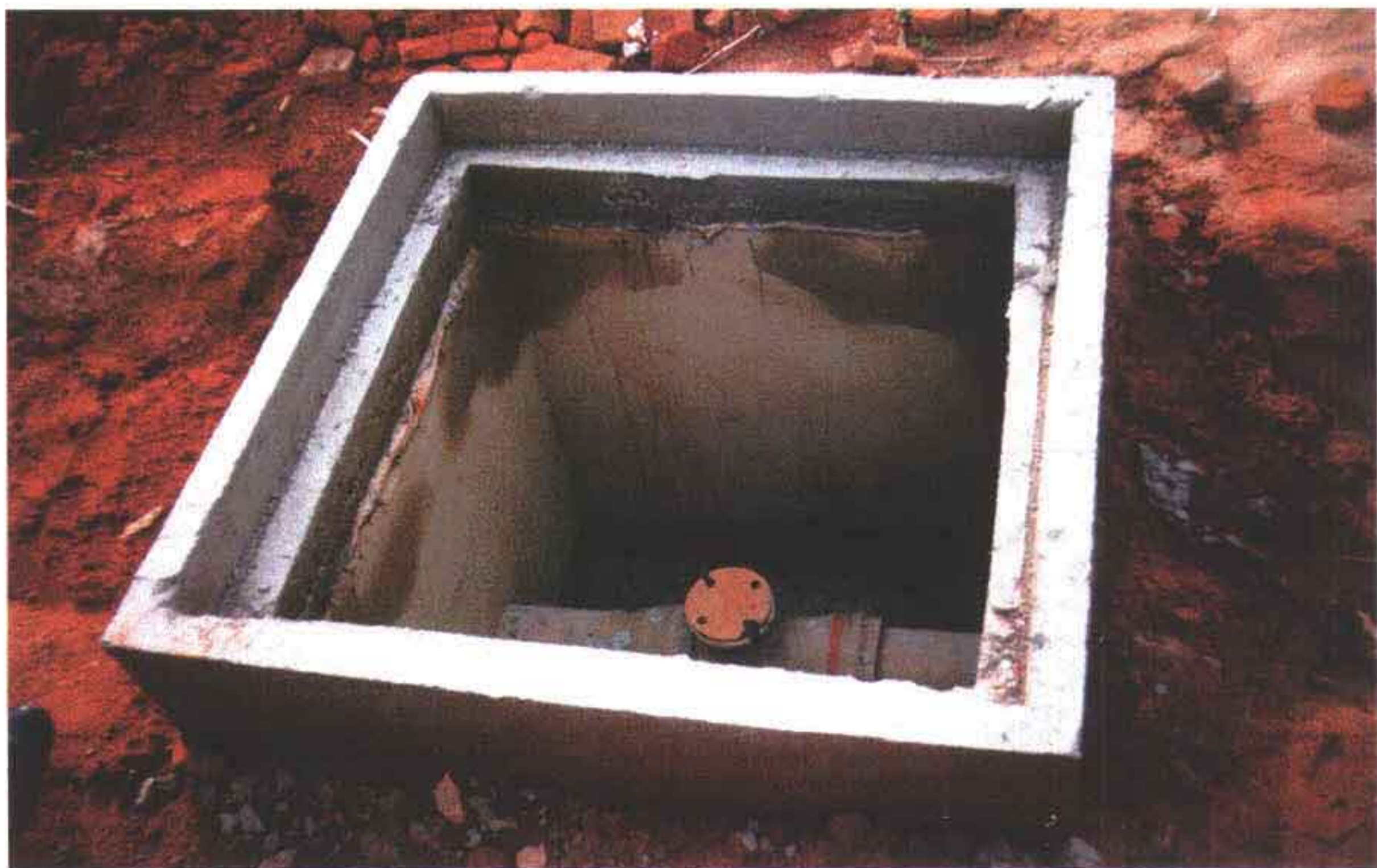
Foto 04 – Detalhe construtivo da caixa para ventosa.
