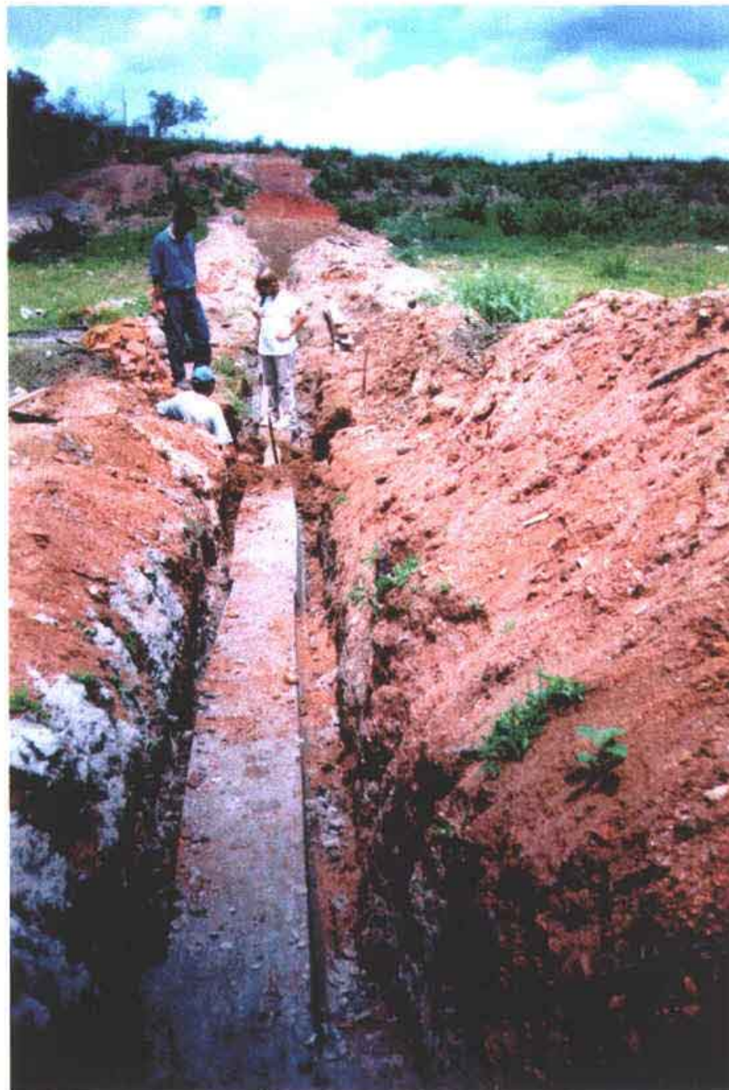
Foto 05 – Envolvamento dos tubos no trecho de área inundável pelas águas do açude São José.
