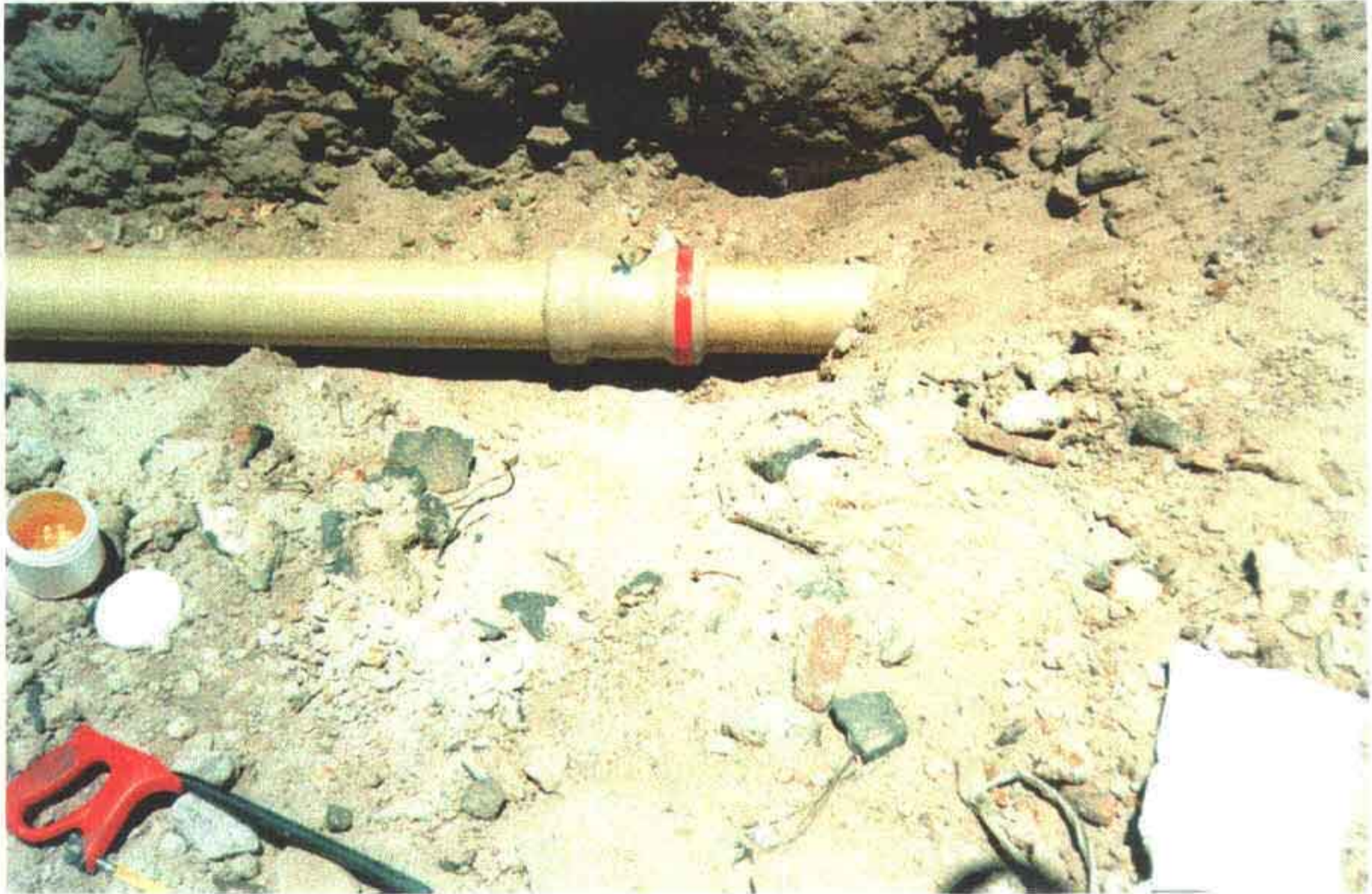
Foto 16 – Centralização da luva de união.
