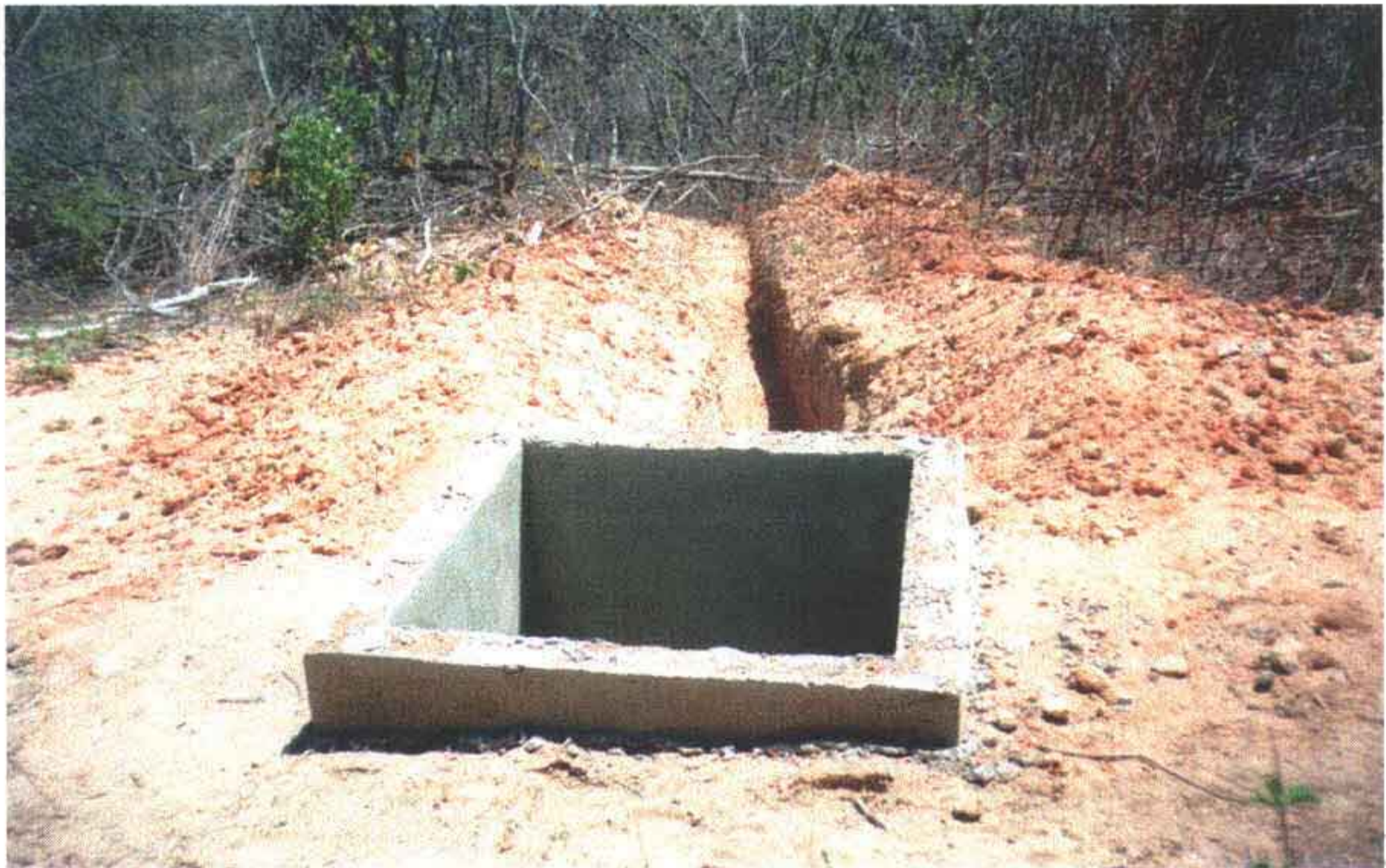
Foto 06 – Caixa para registro – Detalhe da vala para o tubo de descarga.
