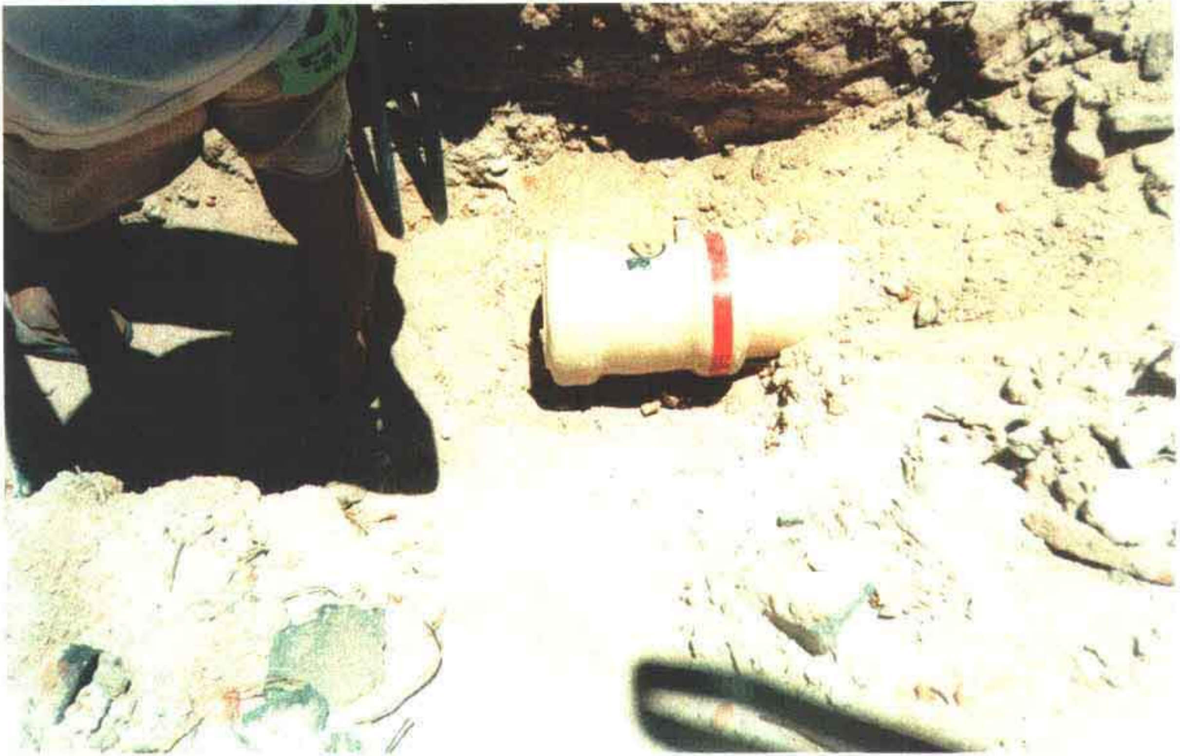
Foto 14 – Instalação da luva. Em uma das extremidades do tubo RPVC.
