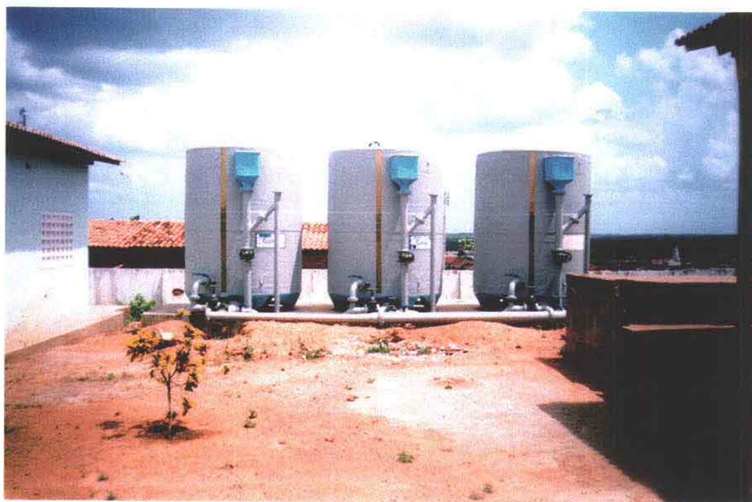
Foto 32 – Filtros clarifiber II – Hemfibra – estão sendo instalados pela construtora responsável pela obras da rede de distribuição da água de Piquet Carneiro na área da ETA.
