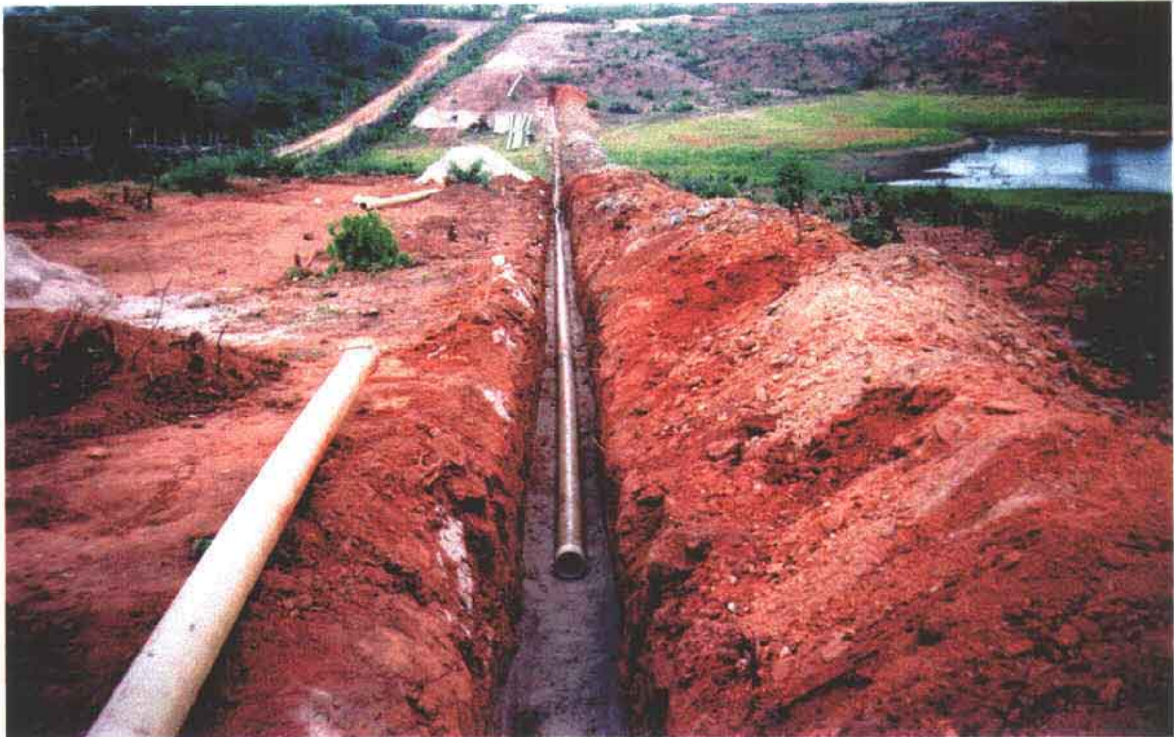
Foto 03 – Vala, colchão de areia e tubos RPVC assentamentos em um dos trechos da adutora do Piquet Carneiro, conforme recomendação do fabricante.
