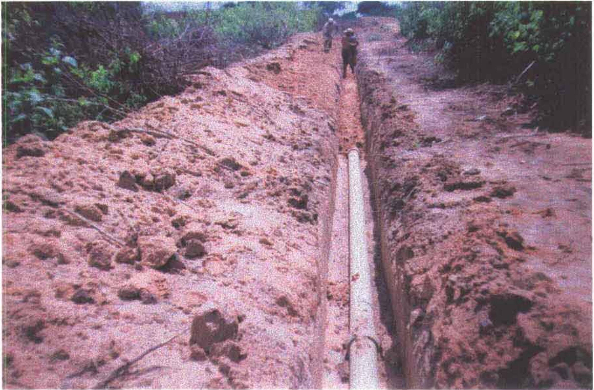
Foto 06 – Vala assentamento dos tubos RPVC e reaterro.
