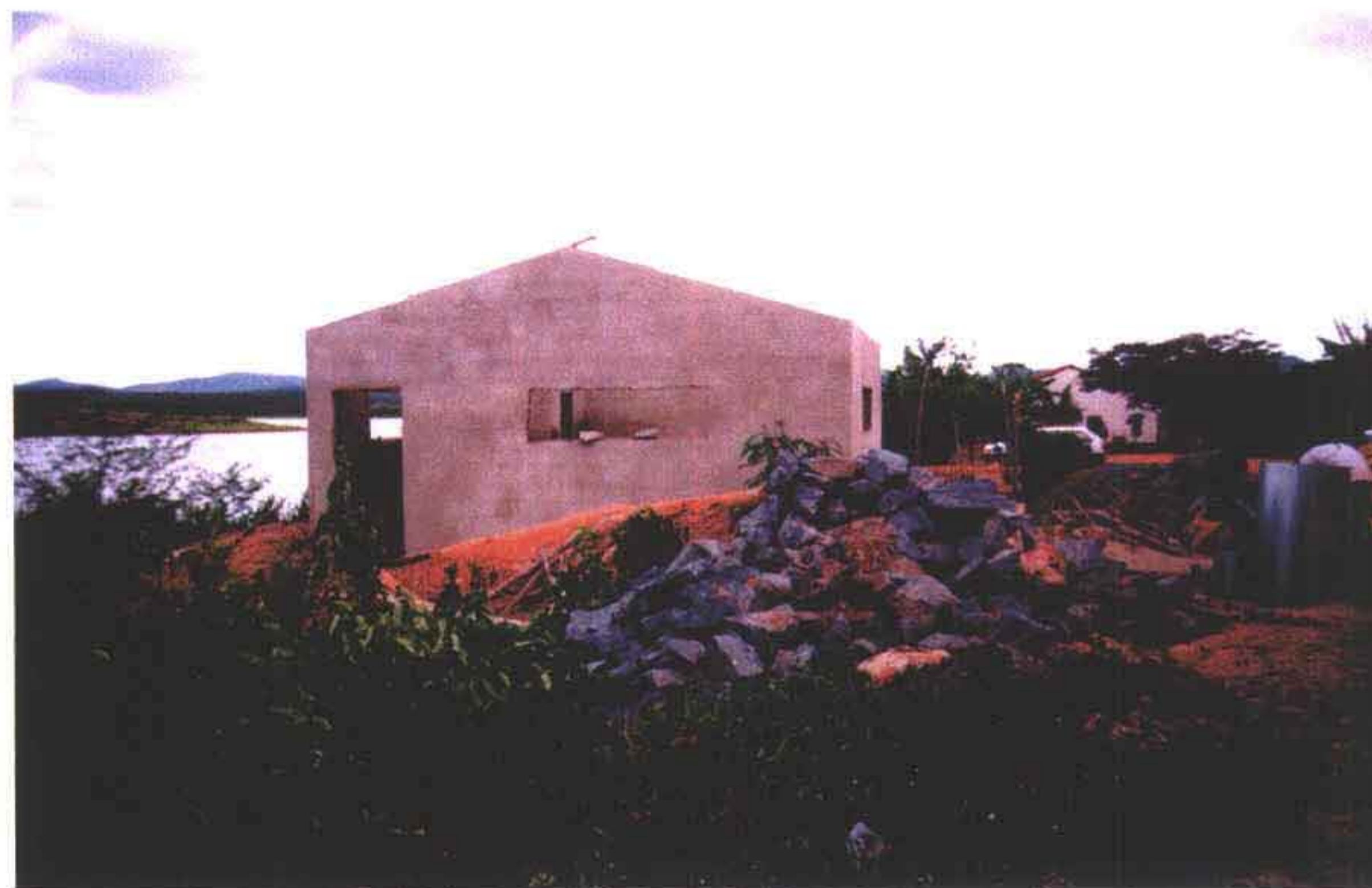
Foto 08 – Estação elevatória EE-2 em construção próximo a captação, casa de bombas.
