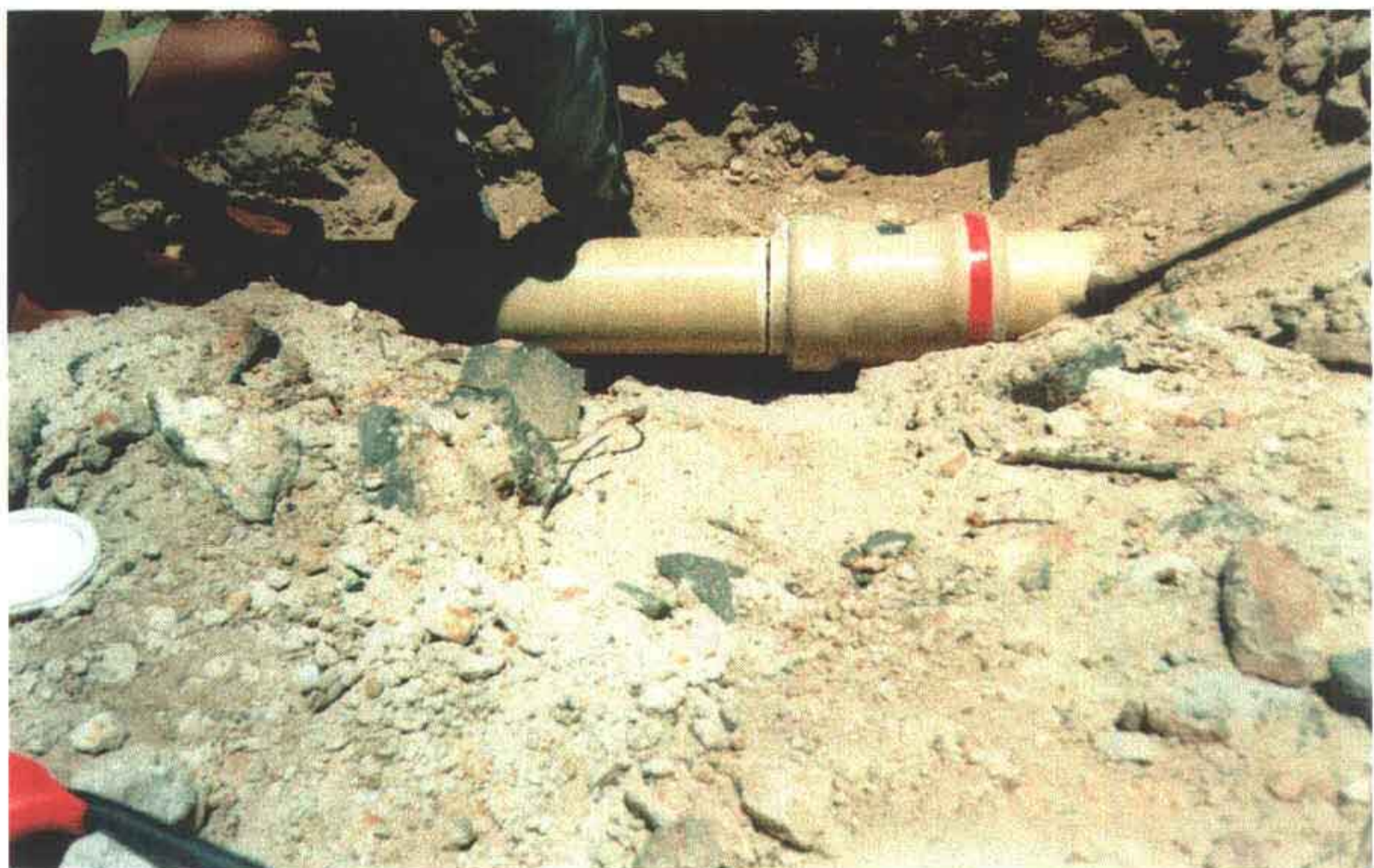
Foto 15 – colocação do complemento do tubo ponto e bolsa em RPVC.
