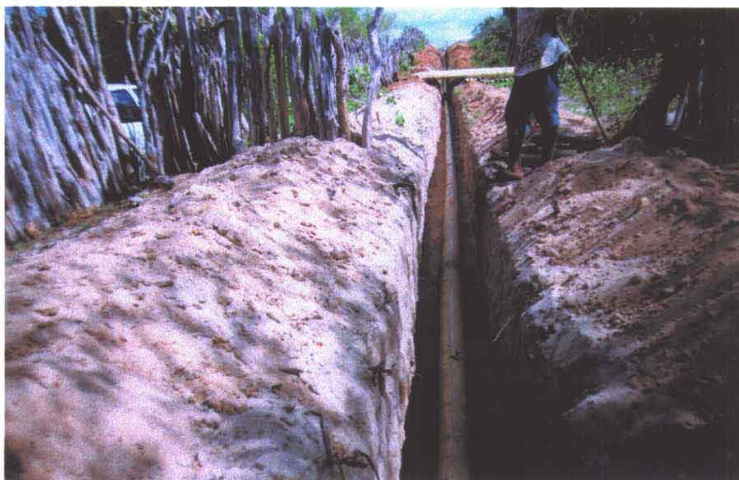
Foto 08 – Tubos assentados sobre berço de areia.
