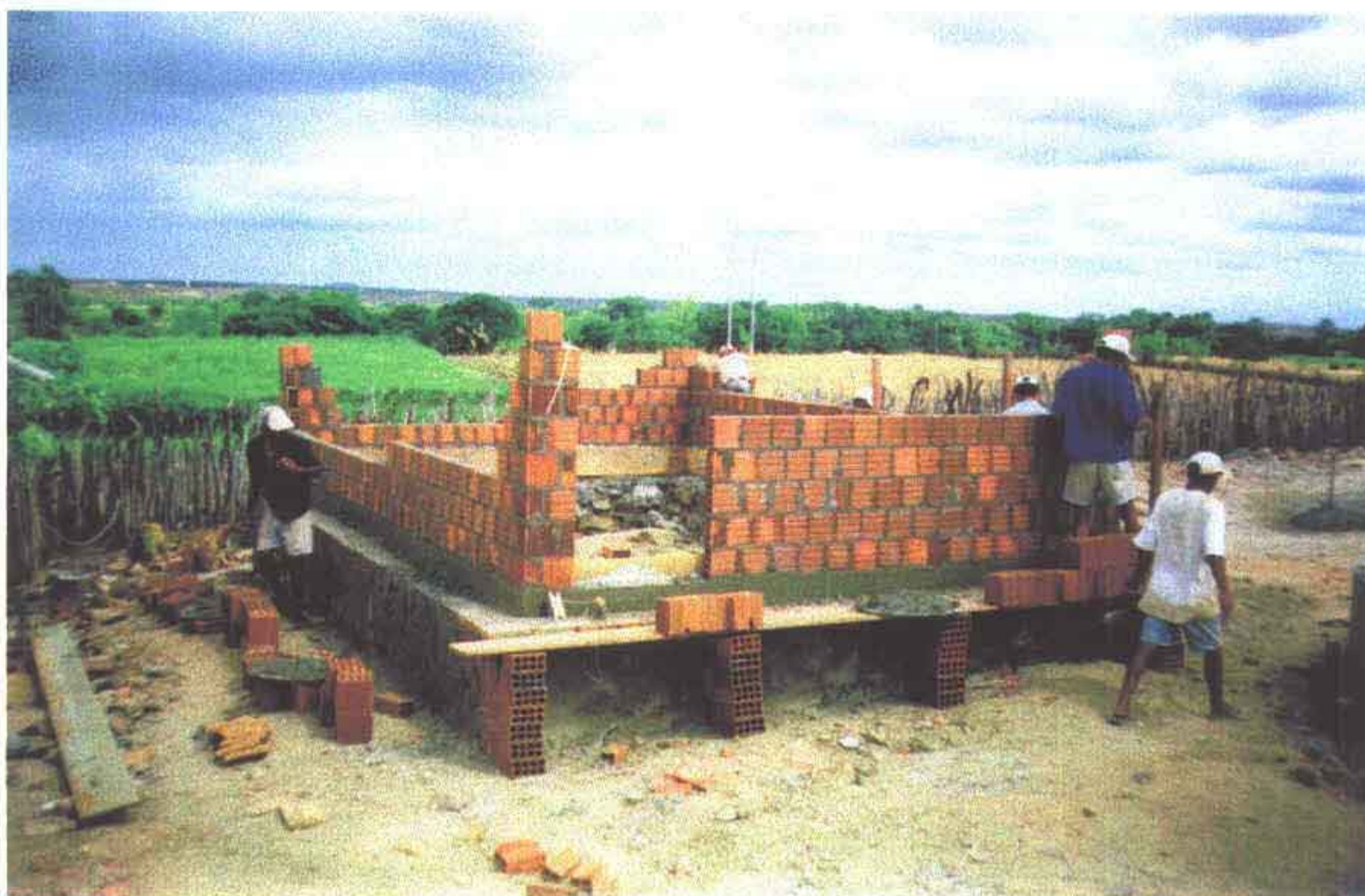
Foto 24 – Casa de bombas de estação elevatória EE-1 – em construção na ETA.
