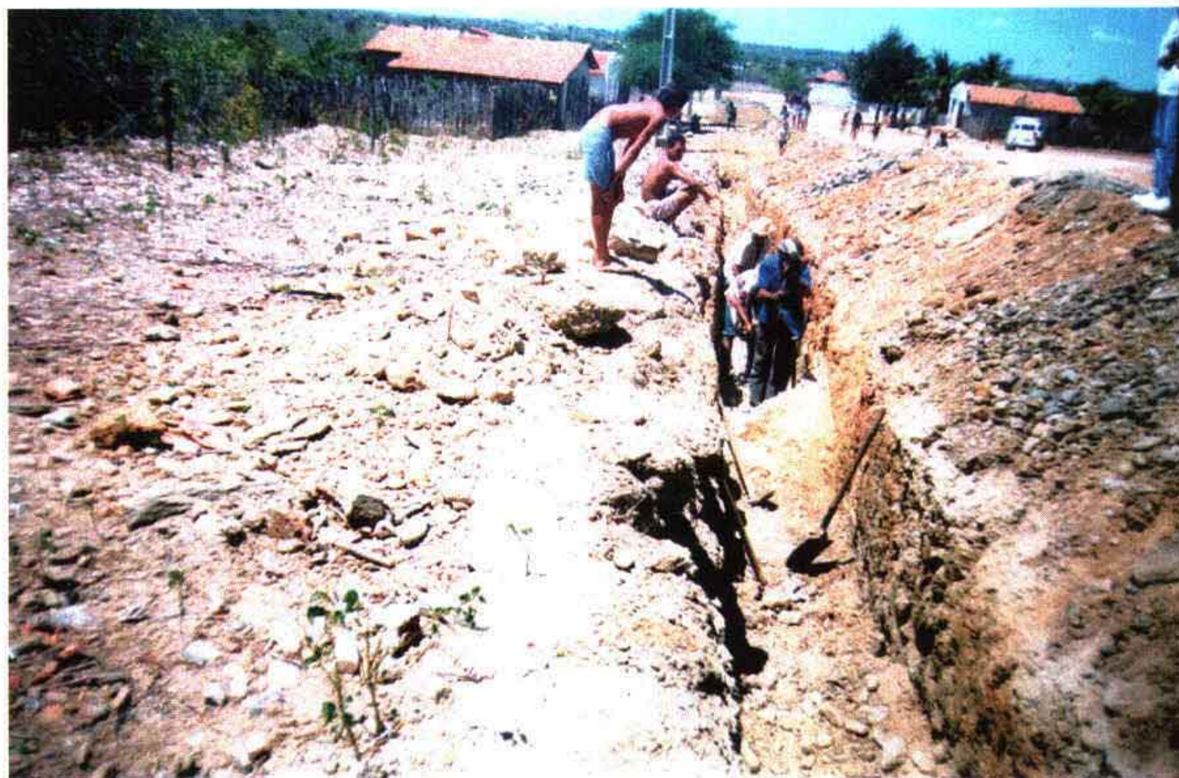
Foto 11 – Escavação em rocha na estrada da cidade de Palhano.
