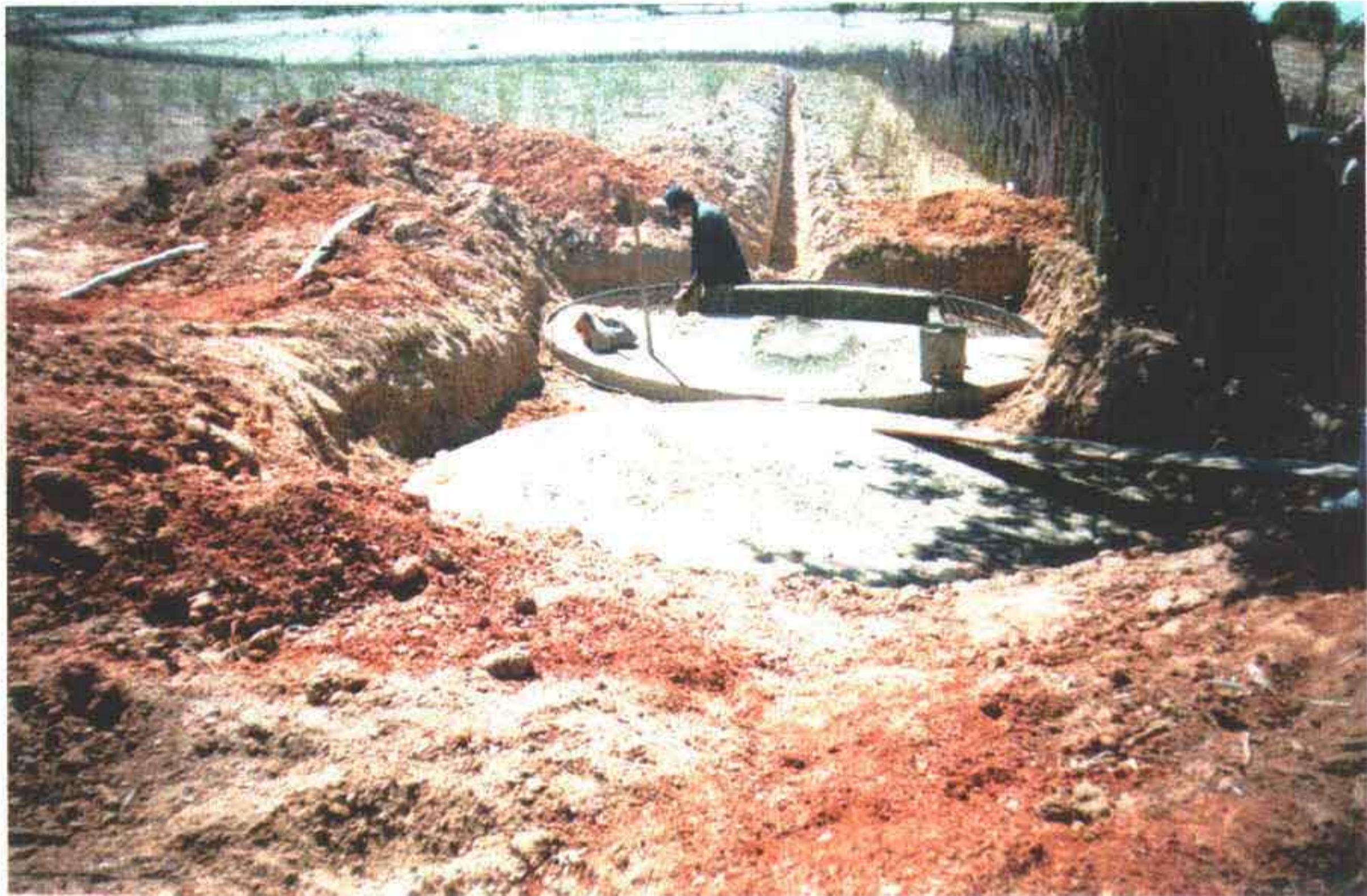
Foto 36 – Laje de fundo do reservatório apoiado de 80 m 3 .
