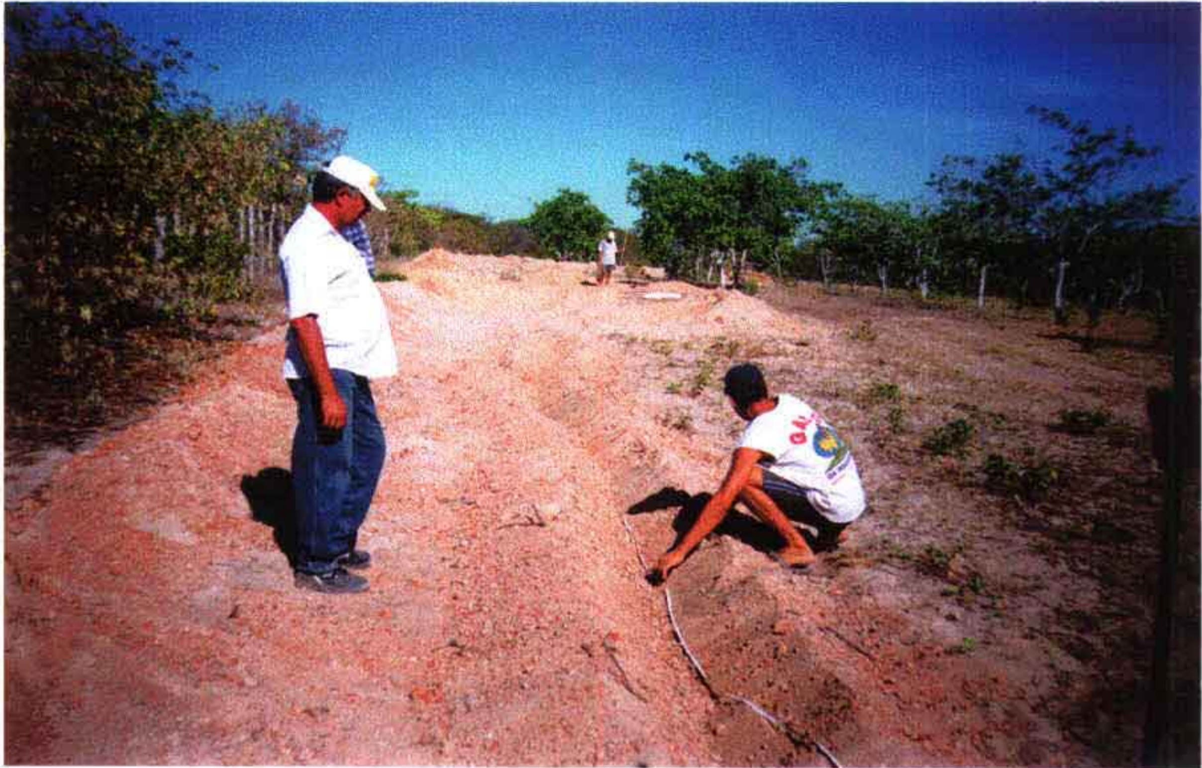
Foto 23 – Verificação pelo topógrafo da consultora o desenvolvimento da curva na estaca 830.
