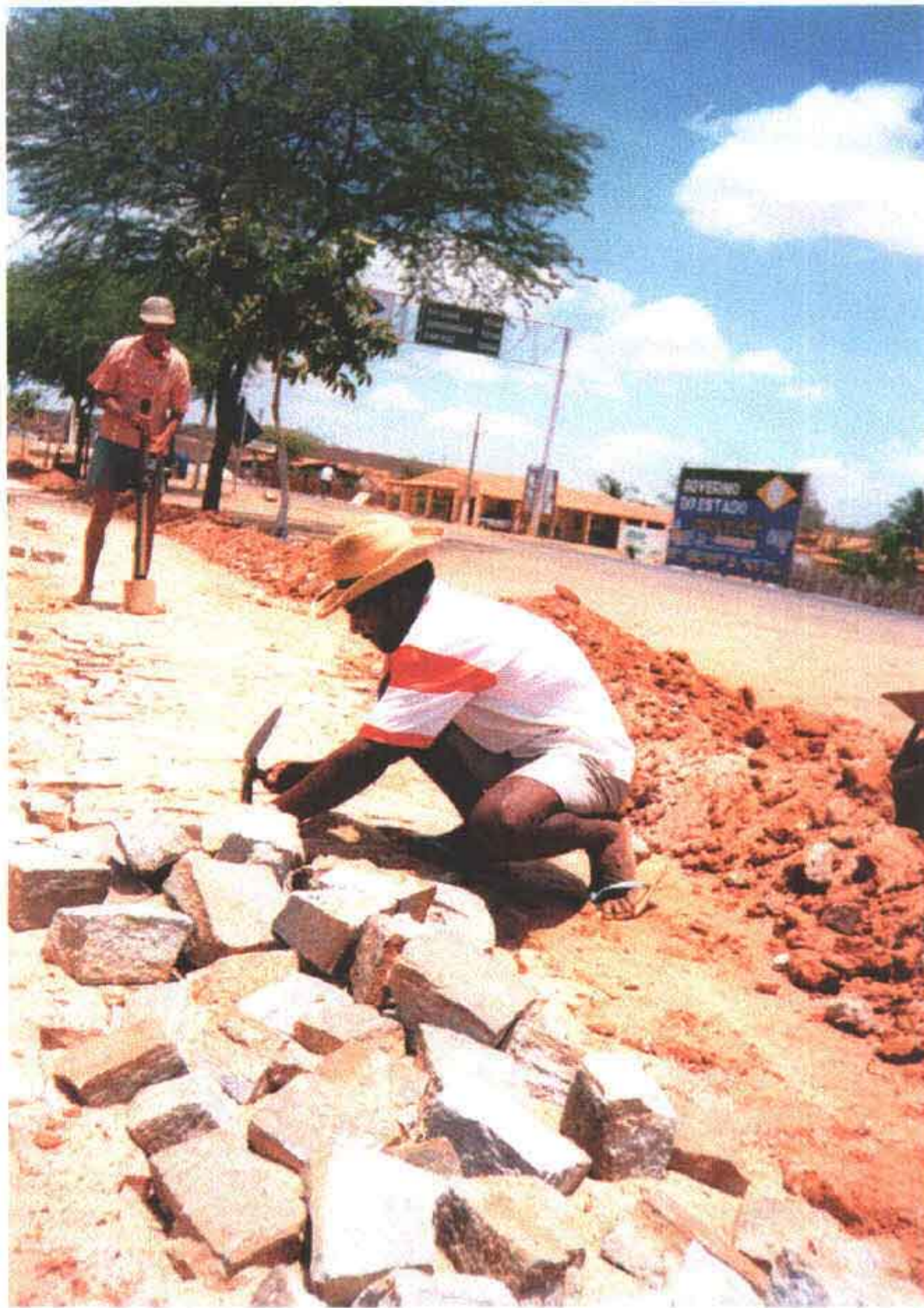
Foto 11 – Recuperação de pavimentação em dos trechos.
