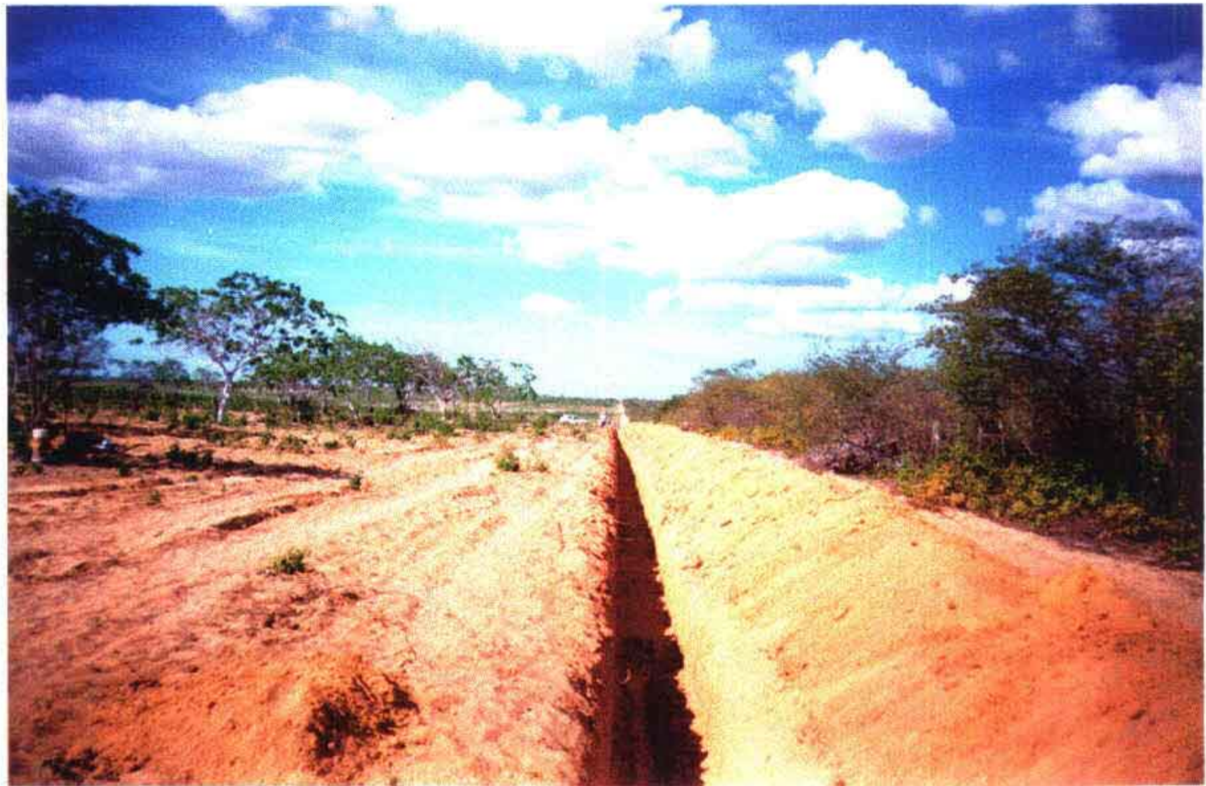
Foto 09 – Escavação da vala no local da 2ª torre Piezometrica.
