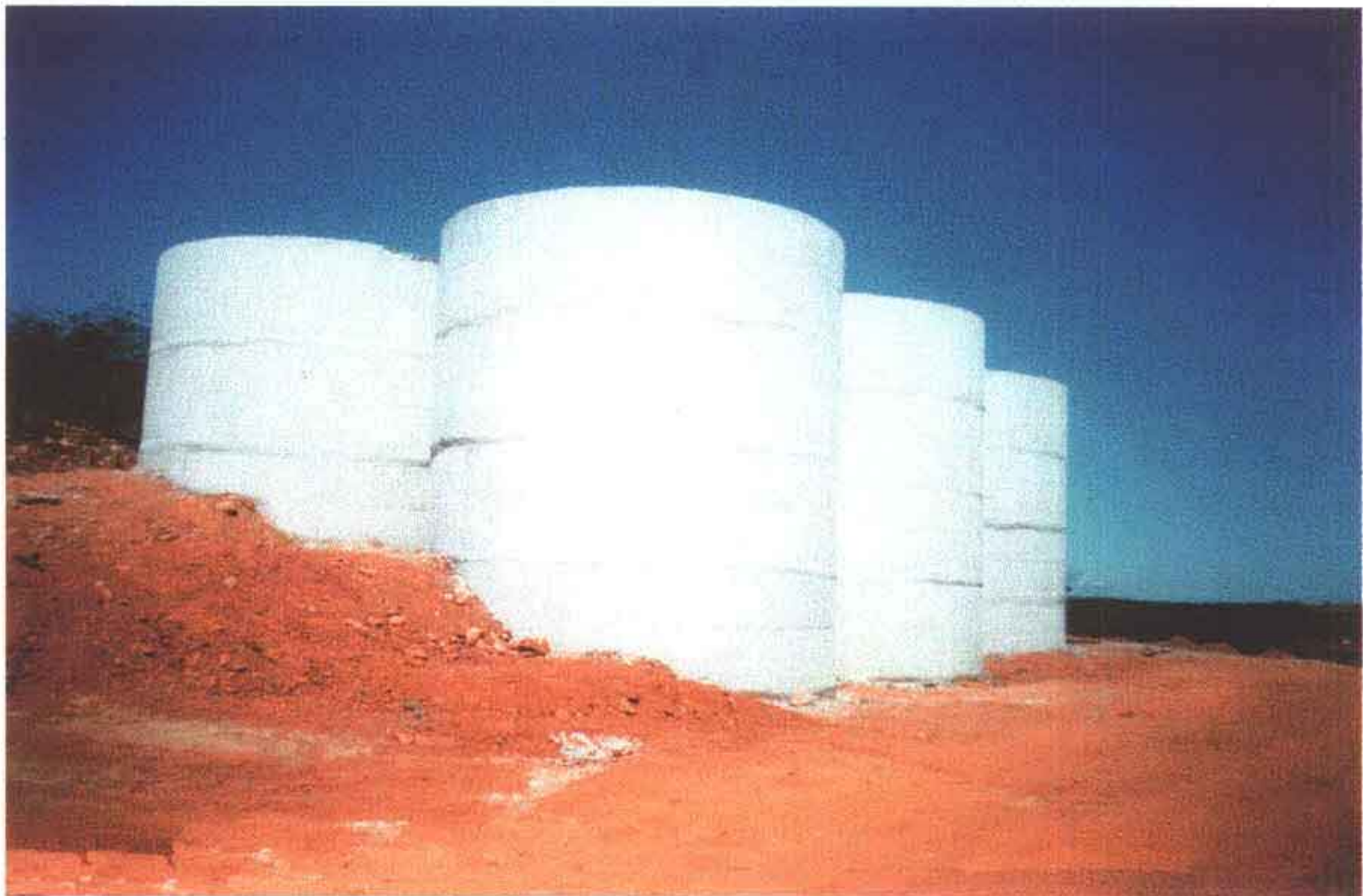
Foto 33 – Concluída a concretagem do reservatório apoiado de 300 m 3 .
