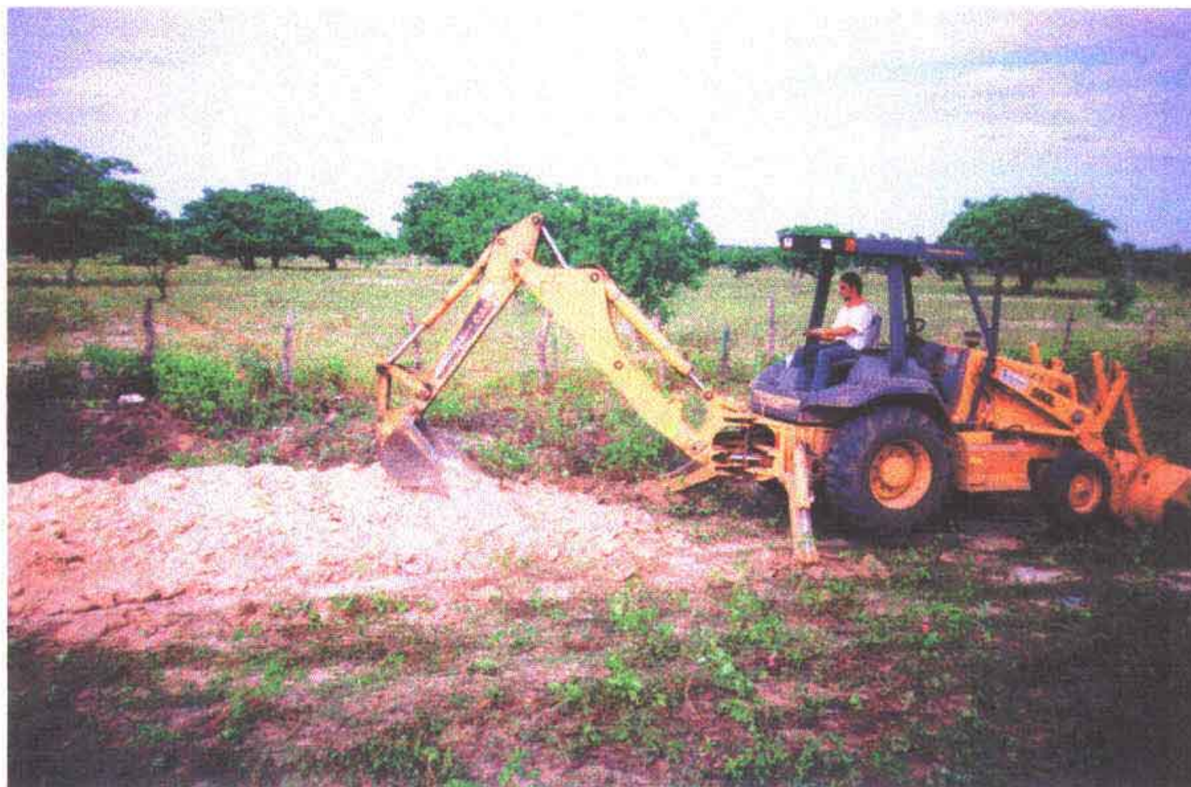
Foto 07 – Escavação de valas com retro-escavadeira.
