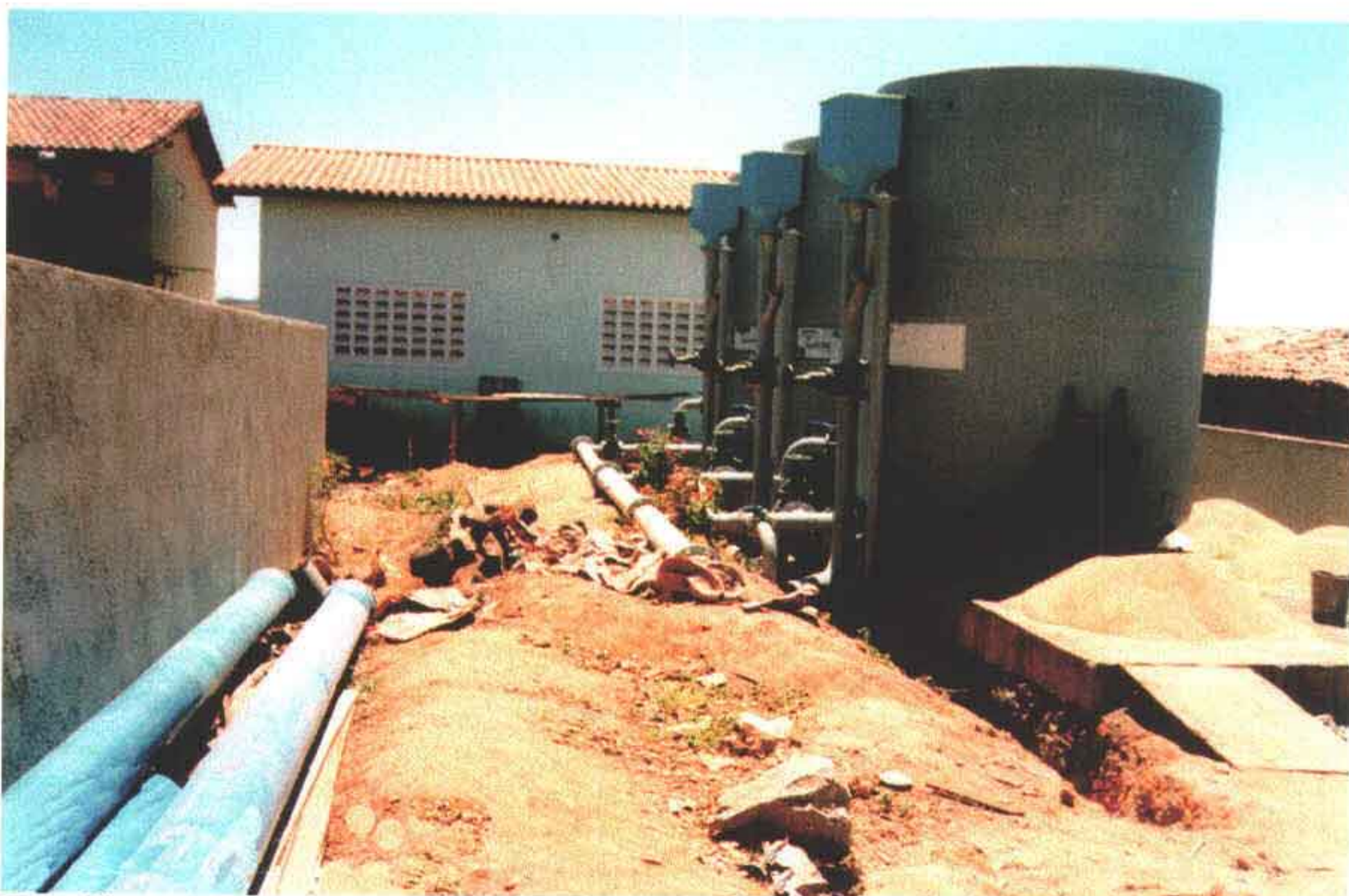
Foto 34 – Vista da casa de Química e filtros na ETA em fase de conclusão pela construtora responsável pelas obras da rede de distribuição.
