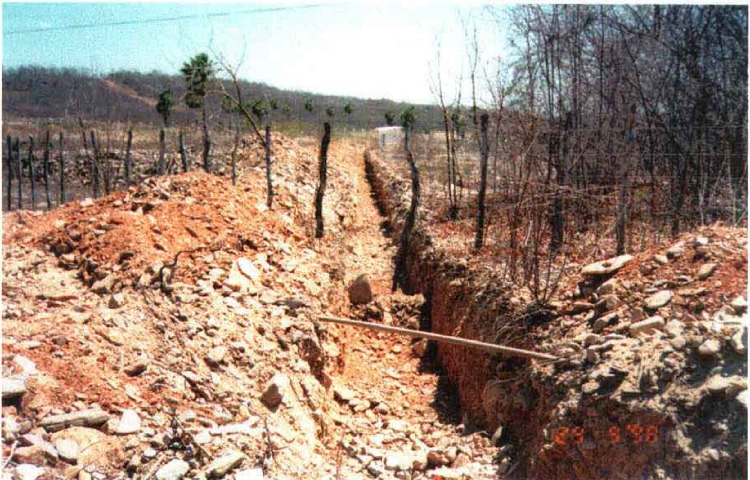
Foto 14 – Escavação de parte da vala próximo a casa de comando na captação.
