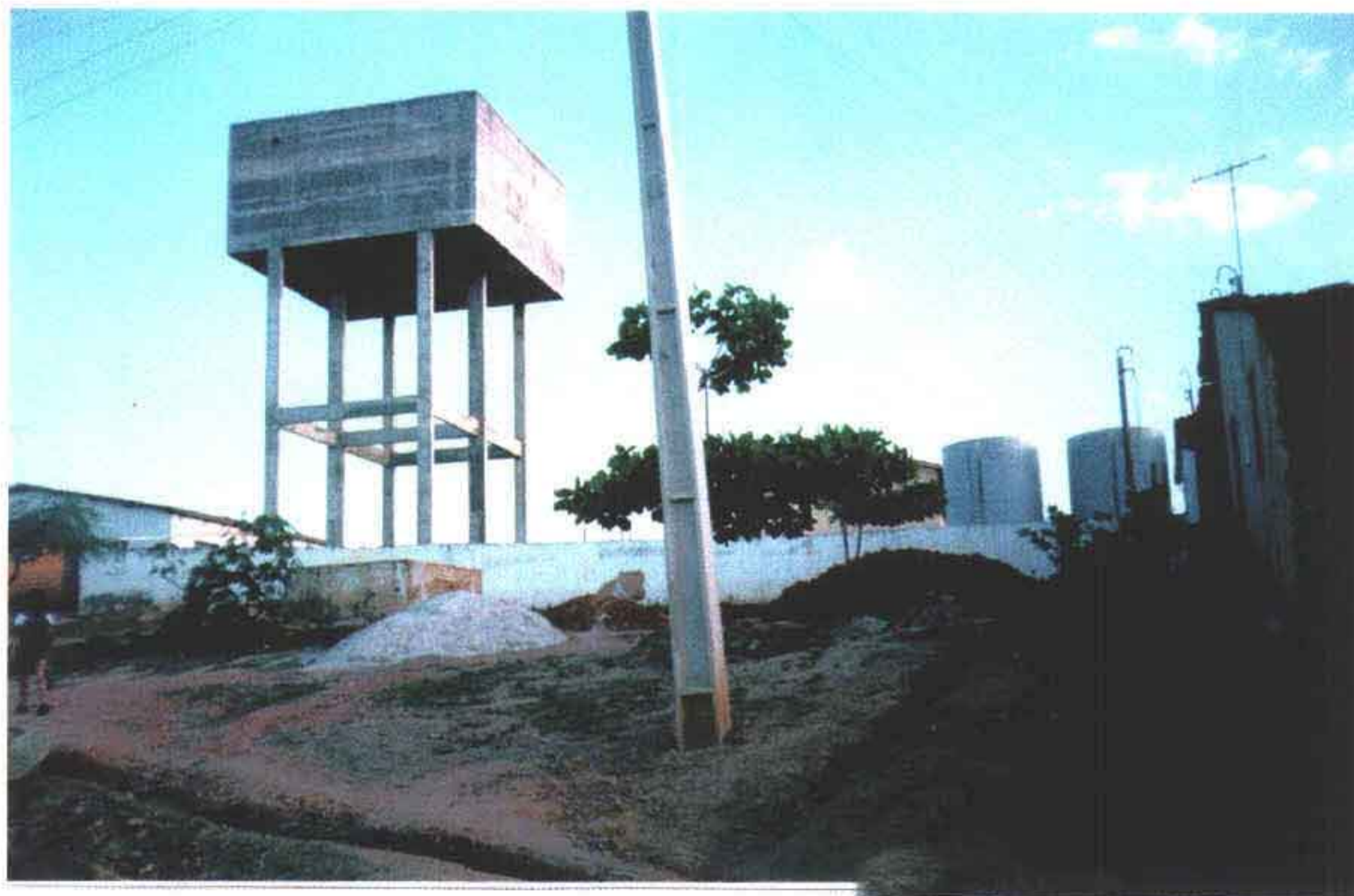
Foto 31 – Reservatório elevado de 200 m 3 construído pela Prefeitura na área da ETA.
