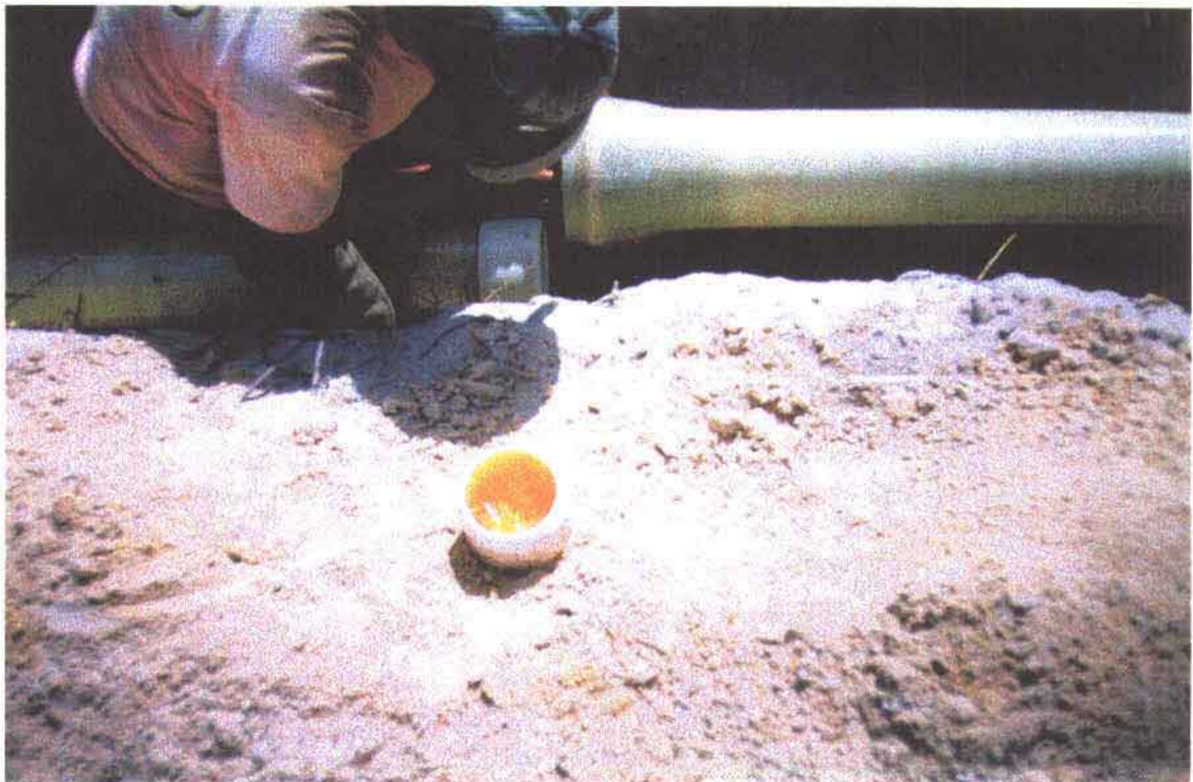
Foto 04 – Limpeza, colocação do anel e pasta na ponta e bolsa dos tubos RPVC.
