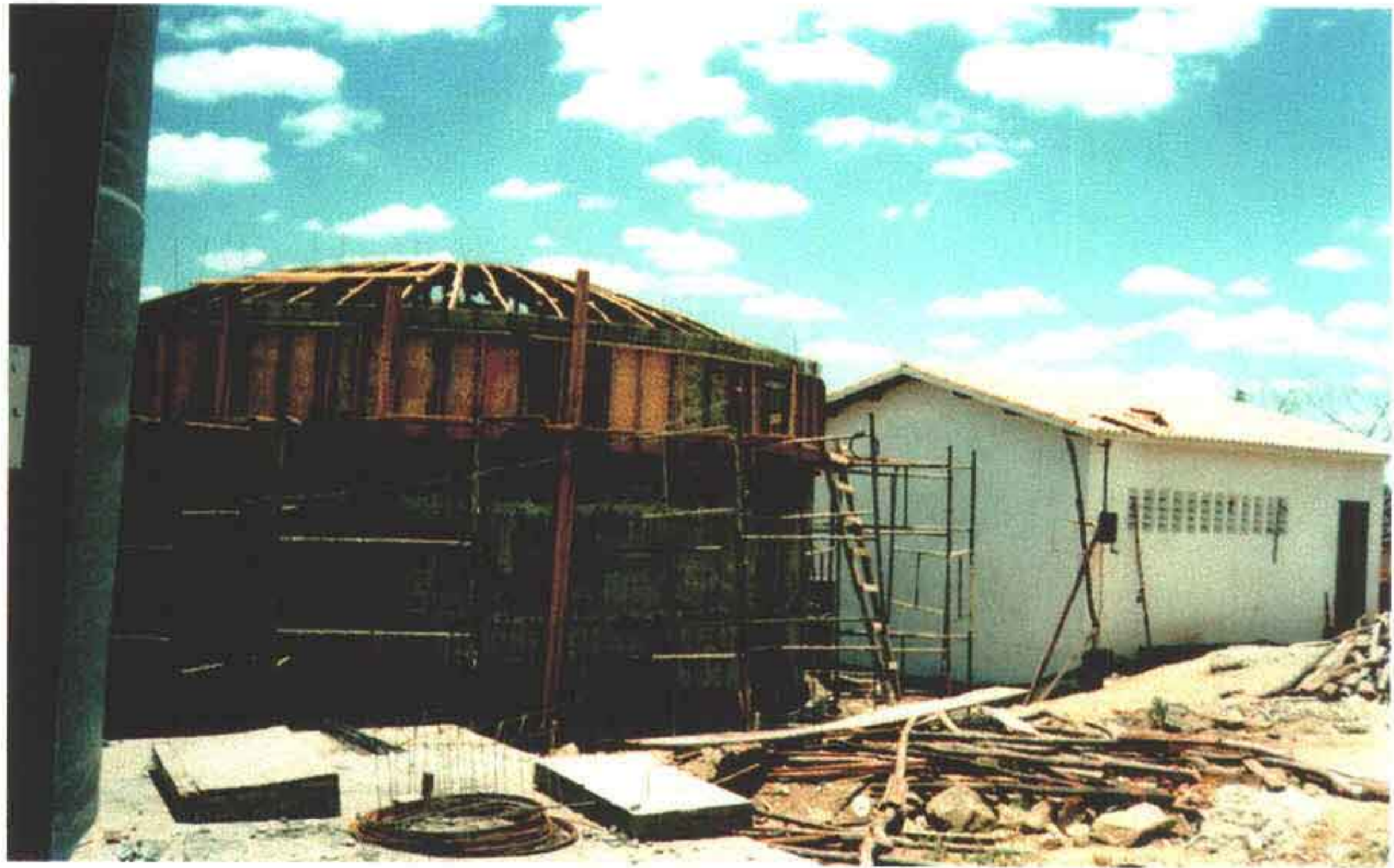
Foto 25 – Estação elevatória – Reservatório apoiado de 200 m 3 e casa de bombas.
