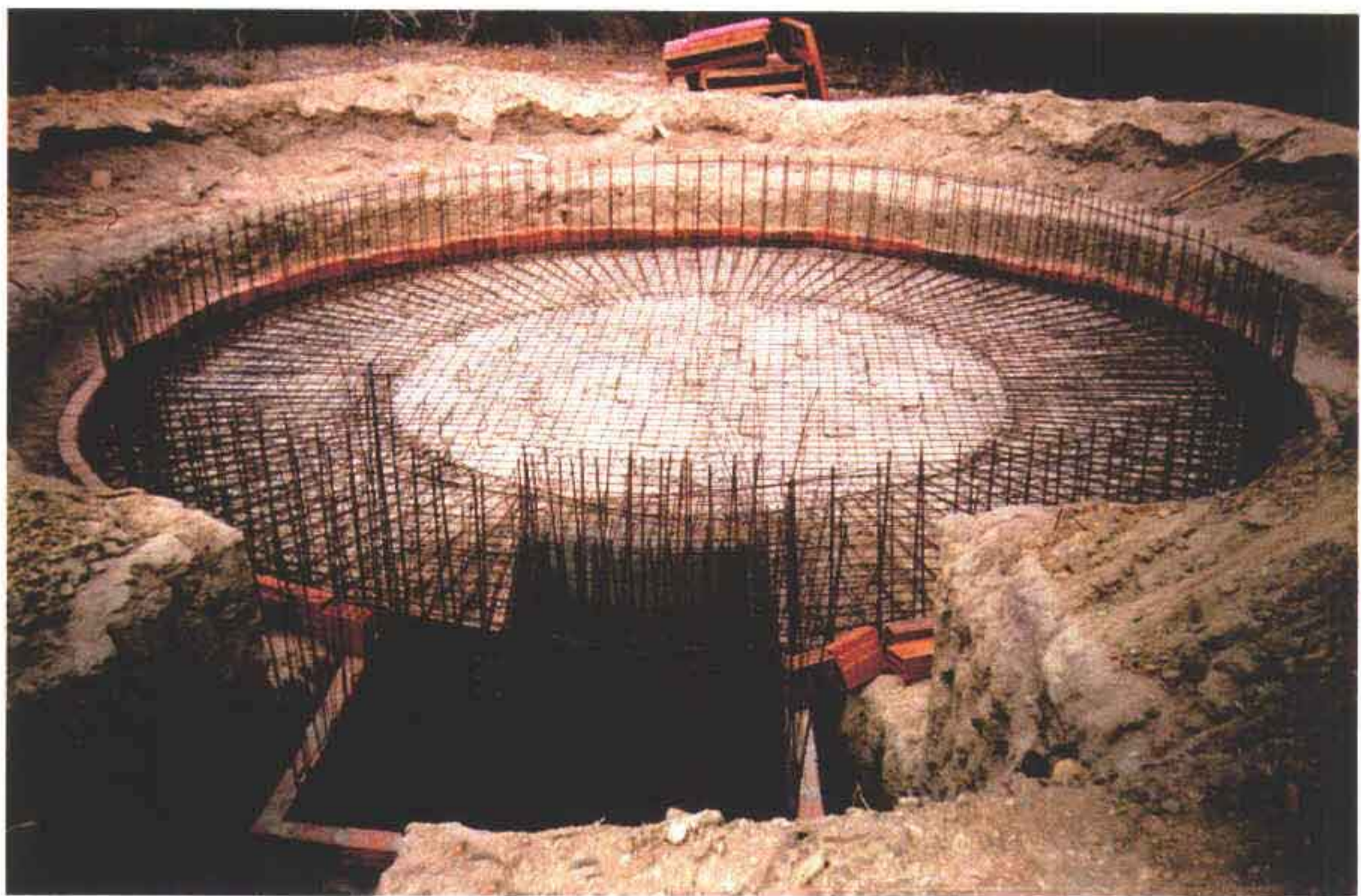
Foto 16 – Ferragens do fundo do reservatório apoiado de 100 m 3 na estaca 250.
