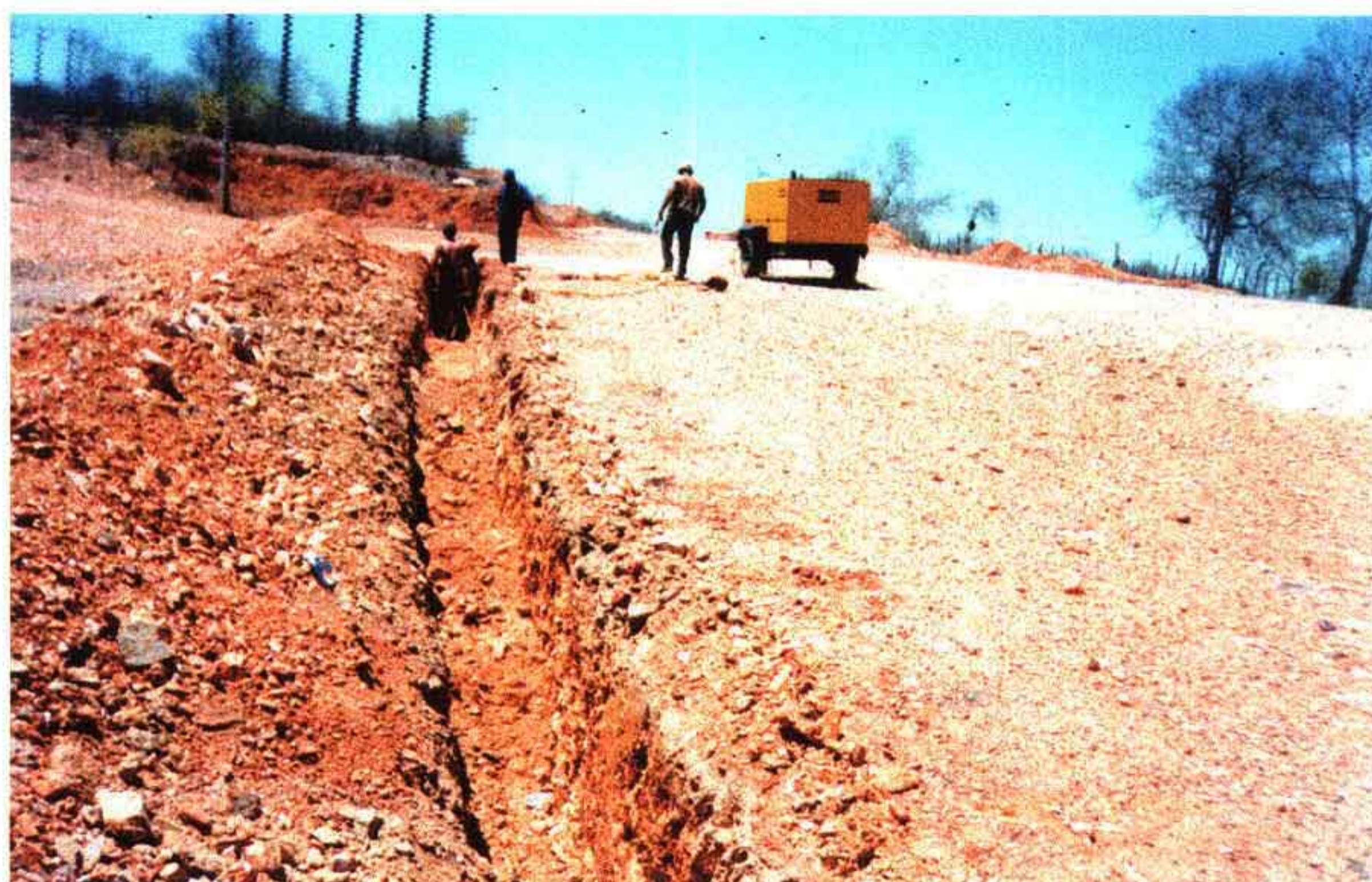
Foto 12 – Escavação de parte da vala com equipamento pneumático.
