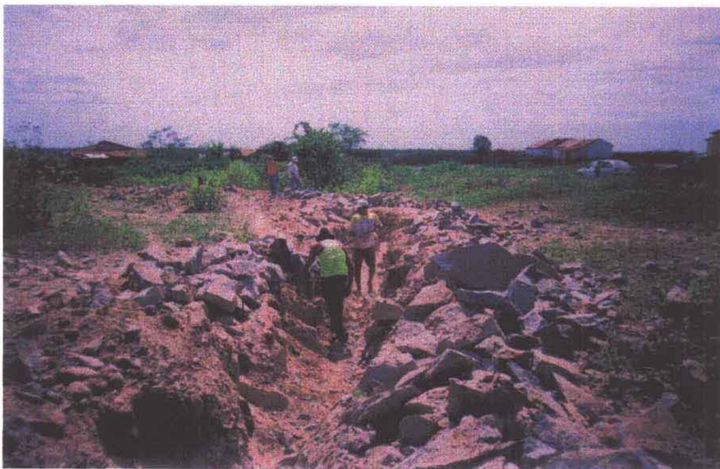
Foto 14 – Limpeza da vala após uso de explosivo.
