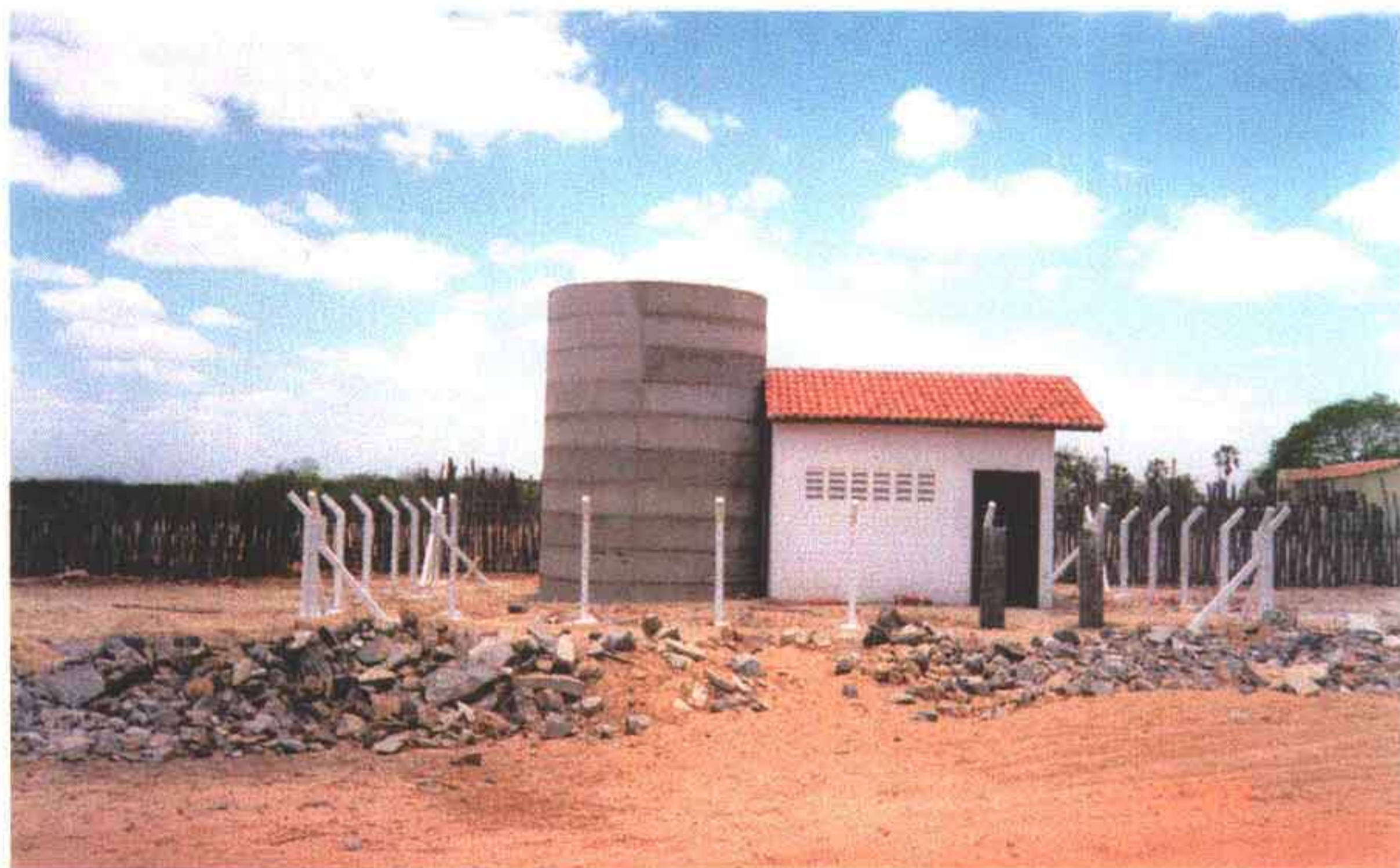
Foto 29 – Estação elevatória EE-3 – Casa de bombas e reservatório de 50 m 3 .
