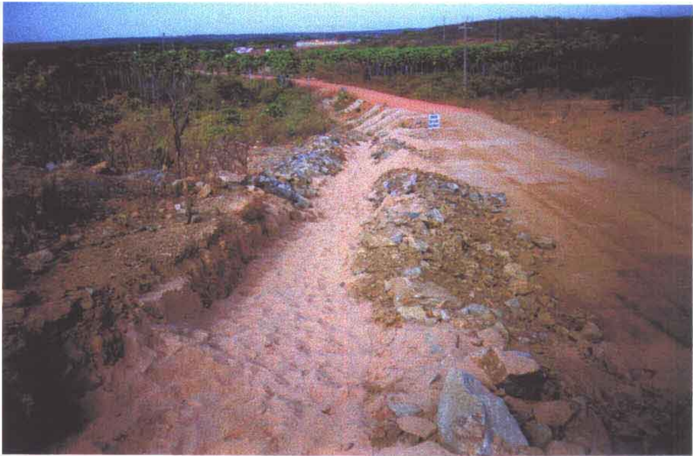
Foto 16 – Reaterro com material de primeira categoria transportado de outro local.
