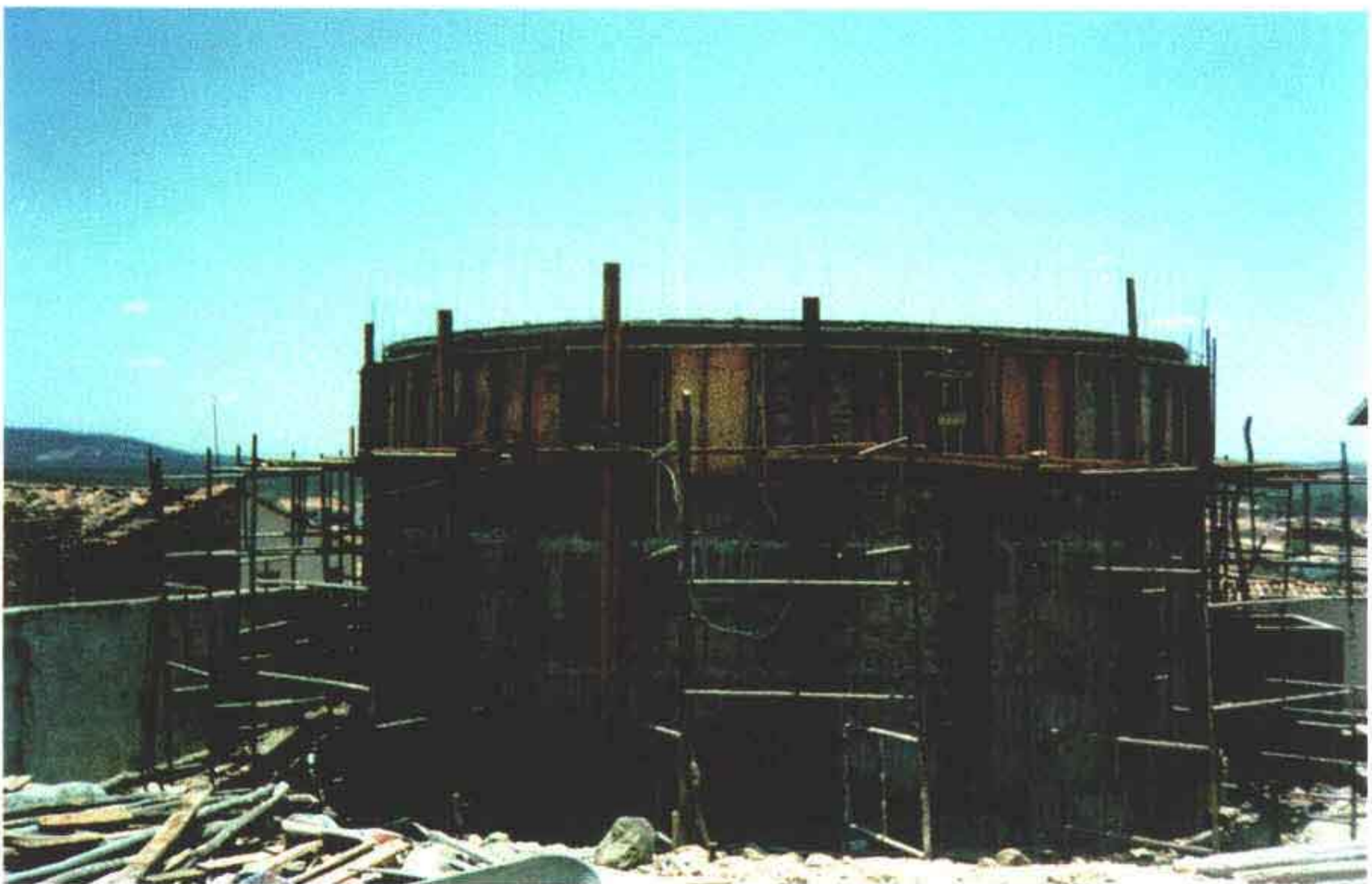
Foto 22 – Concretagem do reservatório apoiado de 200 m 3 .
