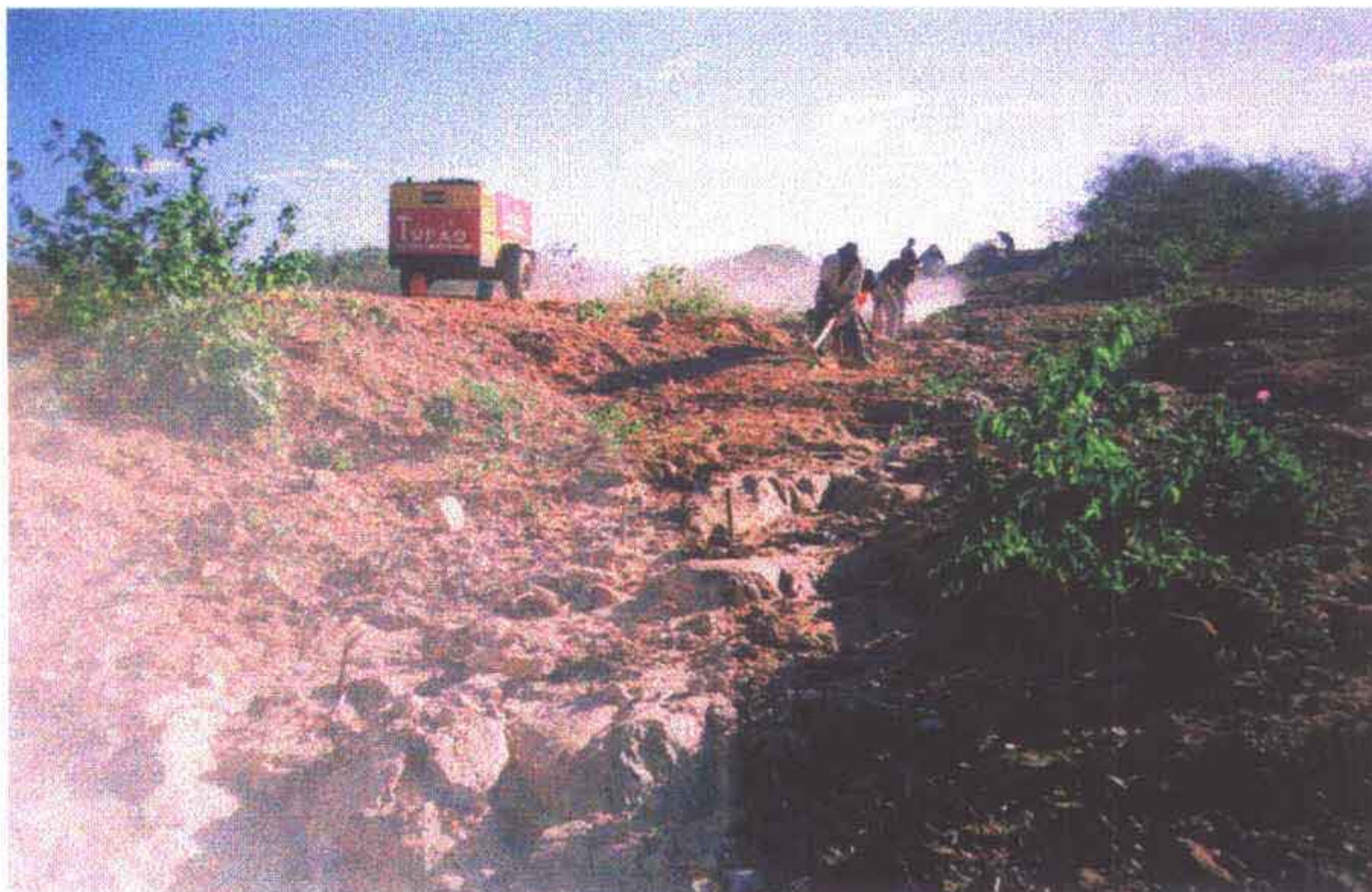
Foto 12 – Escavação em rocha com uso de equipamento pneumático.
